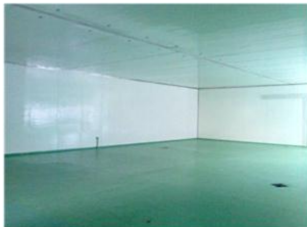
Fotografía 8.15. Piso epóxico con terminación de cáscara de naranja
