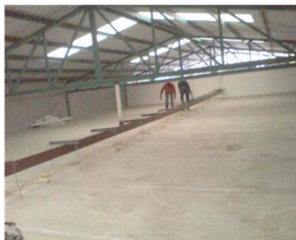
Fotografía 8.17. Espacio entre plafón y techo de estructura metálica
