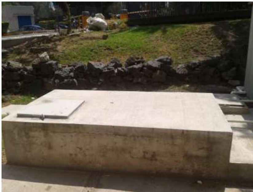
Figura 4-16. Cisterna de la PTAR
