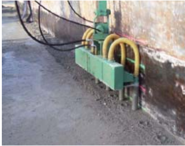
Figura VII-16 Ensayando el MEVR en la losa de ensayo.
