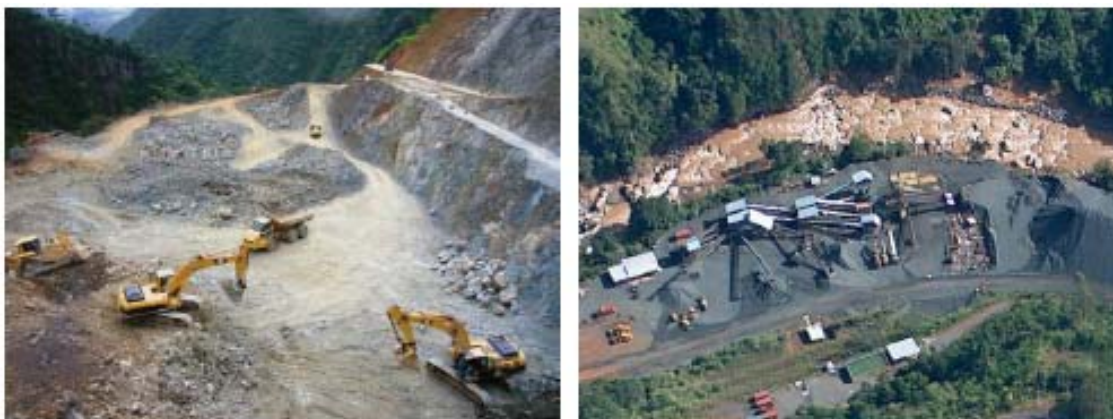
Figura VII-20 Explotación de la cantera y sistema de trituradores.
