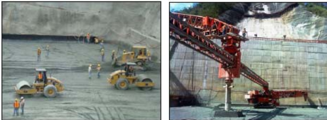
Figura VII-25 Equipos de distribución y compactación del CCR
