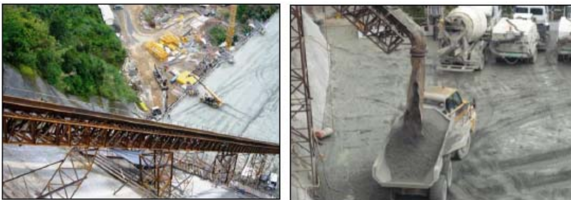
Figura VII-23 Transporte con vagoneta y colocación con canoa
