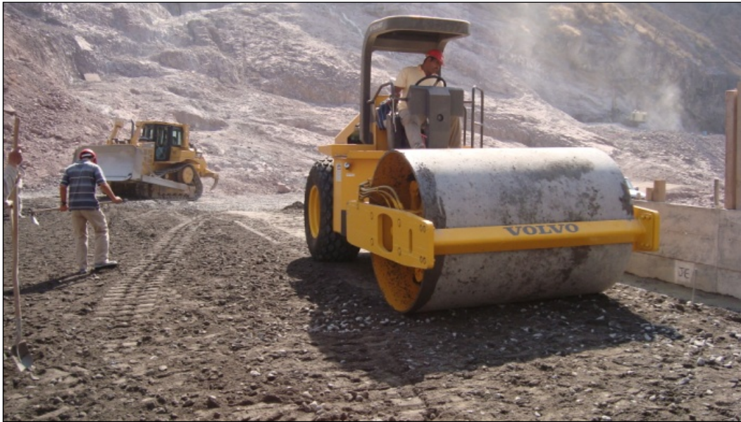
Figura VII-8. Compactación de CCR mediante rodillo
