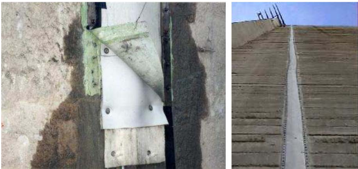
Figura VII-33 Componentes flexibles del waterstop (Izquierda). Waterstop externo instalado en las juntas de contracción (Derecha)
