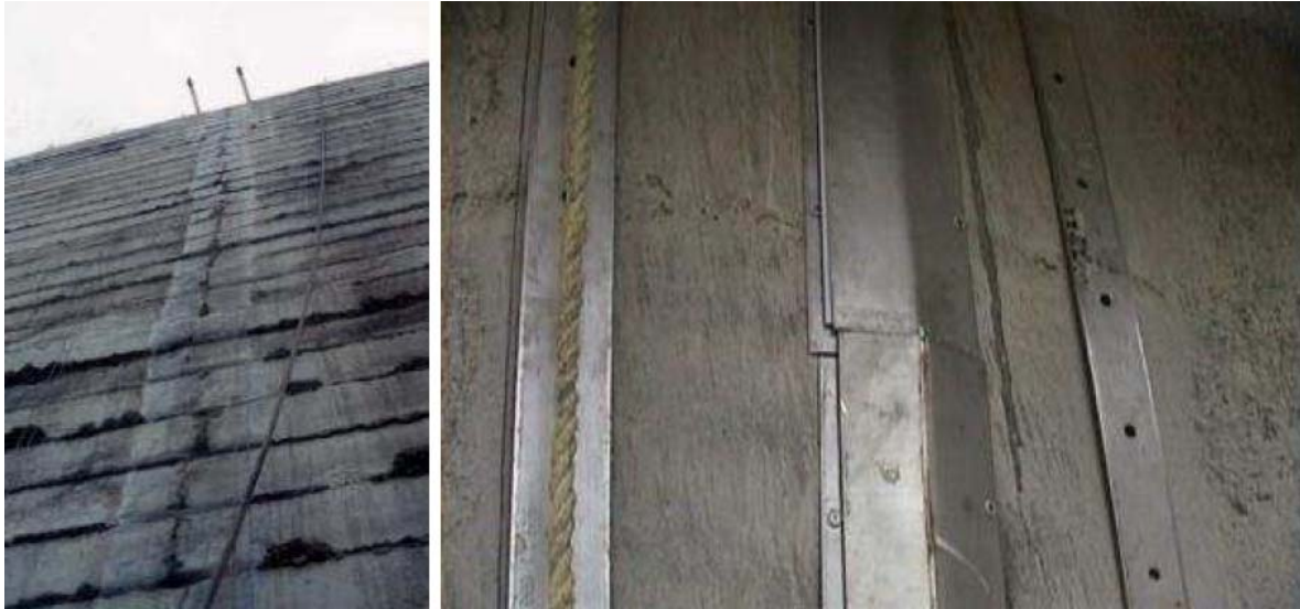
Figura VII-32 Juntas de contracción antes de la instalación del waterstop y placas de acero ancladas a lo largo del borde
