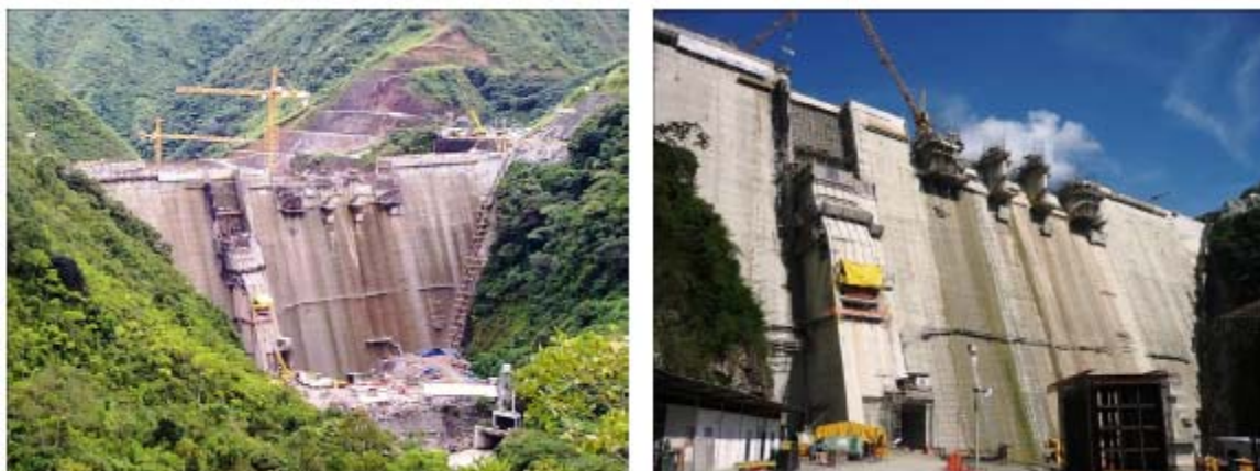
Figura VII-26 Vista frontal de la presa de CCR
