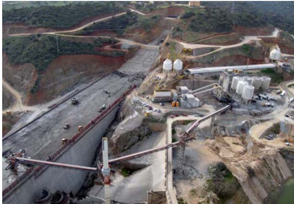
Figura VII-18 Vista general del equipo autotrepante de cintas de transporte del CCR.
