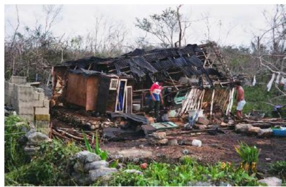
Figura 6.3. Falla de vivienda con material precario en techos y mampostería confinada en los muros, (H. Toledo, 1999).
