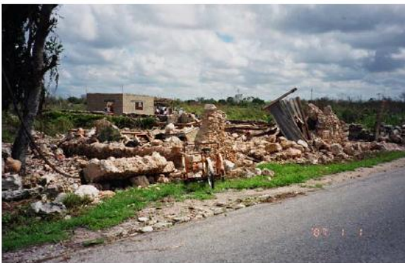
Figura 6.2. Daño en la techumbre de edificación de vivienda tipología de la región, constituida a base de adobe en los muros y material precario en techos.
