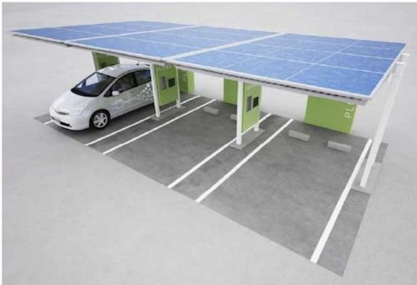
Estación de repostaje de autos eléctricos con captación de energía solar
