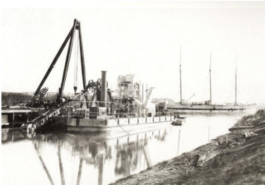
**Imagen 5** “Draga y buque *La María* en el canal del oeste, tomado del terraplén del dique particular” – 18 meses después de emplazadas las obras. Tomás Bradley- Marzo de 1895. (Rivelli, 2007: 87).
