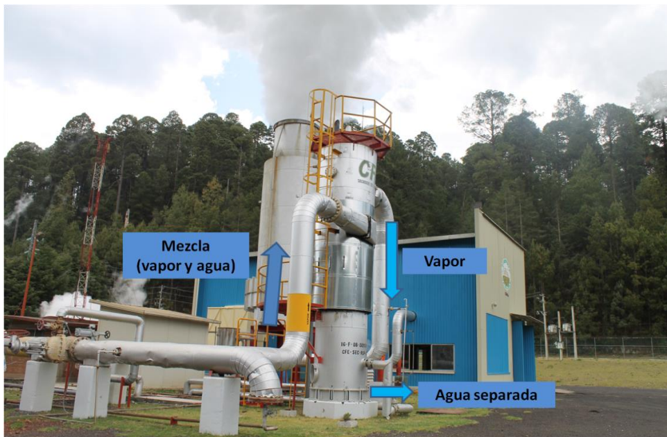
Figura 25.- Separador centrífugo
