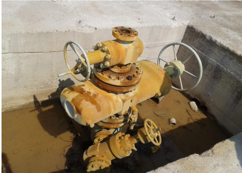
Figura 23.- Pozo Mina Cerro Blanco
