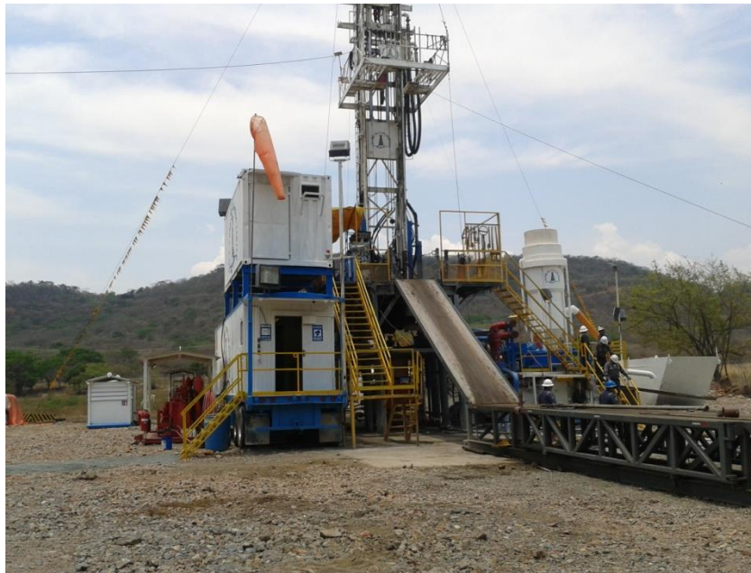
Figura 21.- Equipo de perforación
