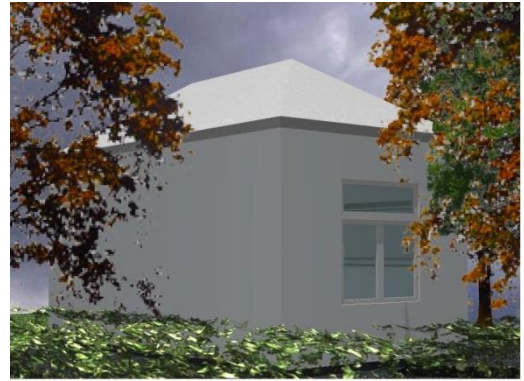
Figura 46. Vista externa de la fachada noroeste del recinto acondicionado.
