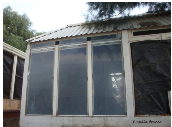
Figura 14. Fachada de cancelería y acrílico de la zona III
