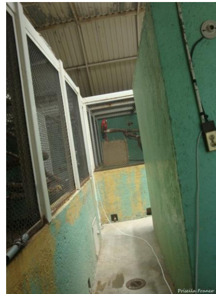
Figura 8. Vista interna de la zona I.
