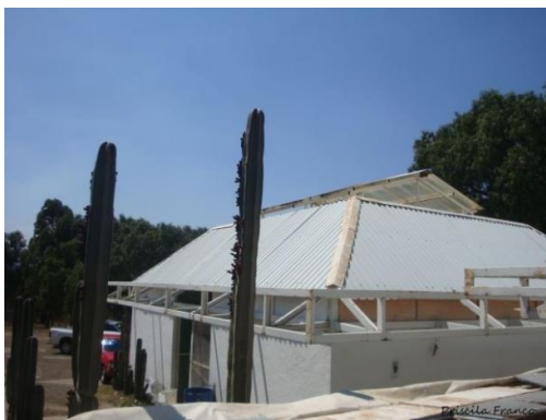
Figura 6. Vista exterior de la zona I.
