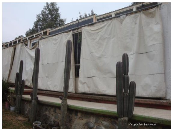
Figura 10. Fachada de cancelería y lona de la zona II
