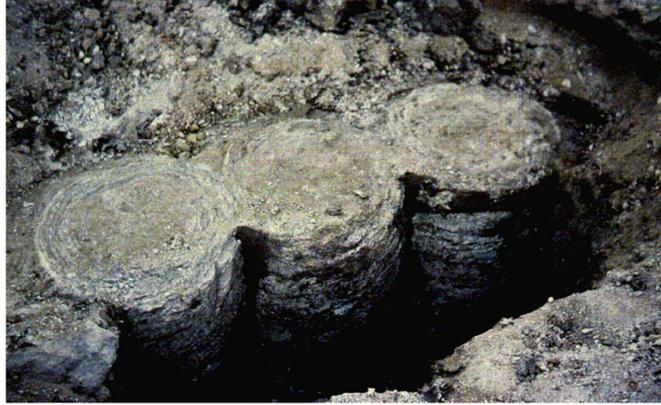
**Figura 3.17 Columnas de cal-cemento mezcladas in situ (Rodríguez, 2001)**
