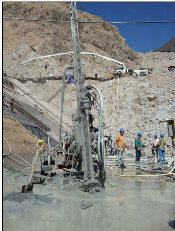
Fotografías 6.1 y 6.2. Equipos de perforación tipo Track Drill con martillo de fondo.
