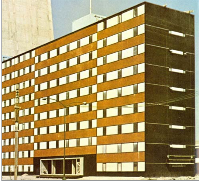
Edificios tipo B (detalle de fachada)/Fuente: Conjunto Urbano Nonoalco-Tlaltelolco . México: BANHUOPSA, 1963. p.72
