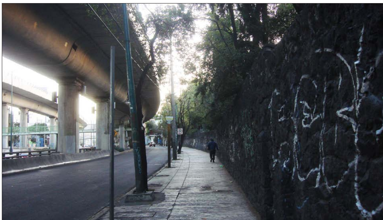
Muro perimetral de piedra de la Unidad Independencia sobre Periférico Sur (2010)
