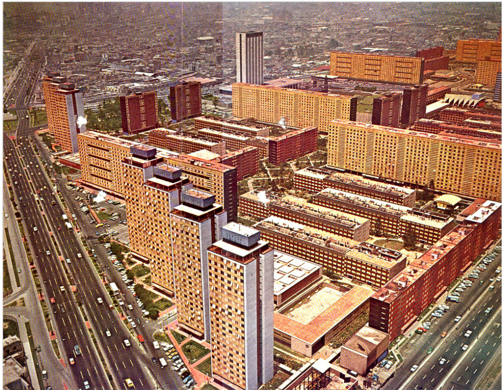
Vista aérea del conjunto desde el noreste hacia finales de los años sesenta del siglo XX
