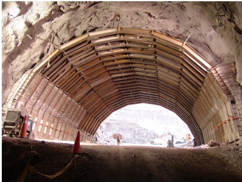
Figura 161. Estabilización de los primeros metros de excavación mediante marcos metálicos (CFE P.H El Cajón).
