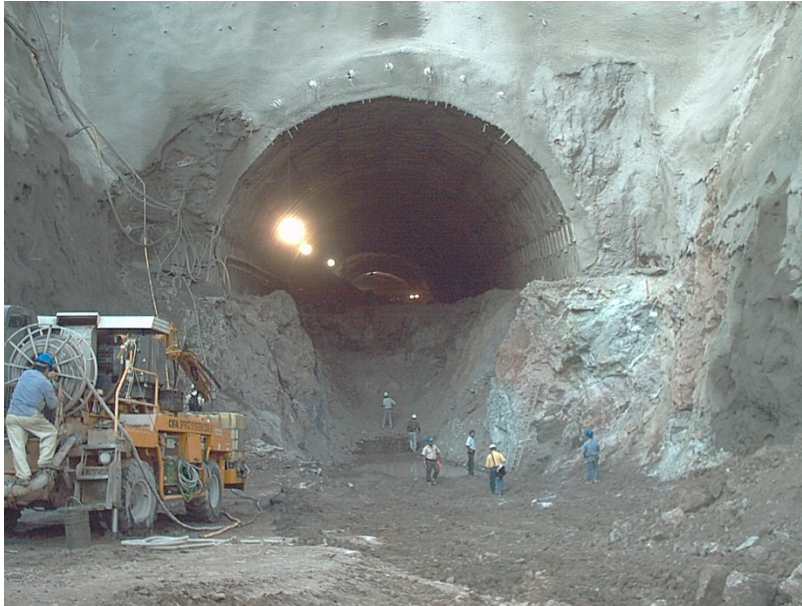
Figura 159. Excavación mediante el Nuevo Método Austriaco (NATM, por sus siglas en inglés).
