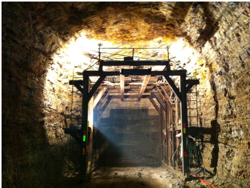
Figura 156. Excavación mediante perforación y voladura (P.H Coca Codo Sinclair, Ecuador).
