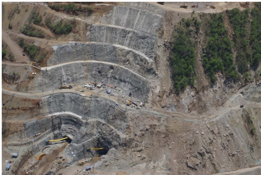
Figura 155. Excavación a cielo abierto para realizar el emboquille (CFE, P.H La Yesca).
