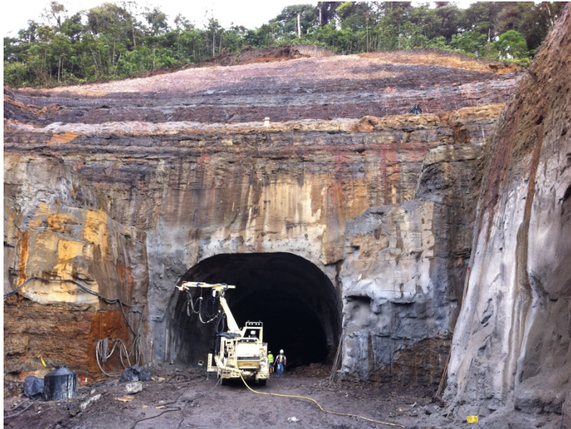
Figura 160. Anclaje radial para estabilización del portal (P.H Coca Codo Sinclair, Ecuador).
