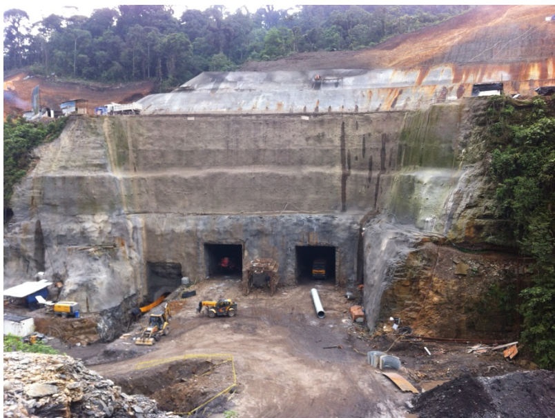
Figura 162. Modificación de la geometría de los taludes que conforman el emboquille (P.H Coca Codo Sinclair, Ecuador).
