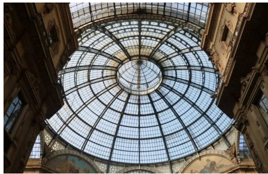
Imagen I.47 Detalle del domo central.
