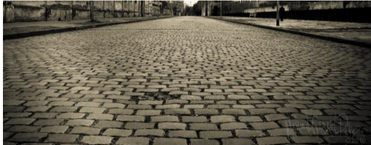
Imagen III.41. Ejemplo de aplicación de materiales reductores de velocidad.
