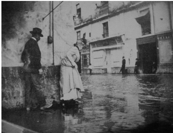
Figura 3.1.- Inundaciones en la Ciudad de México.
