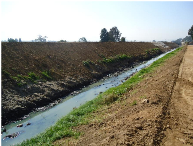
Figura 3.8.- Bordo de Protección en el Río San Francisco en Chalco, Estado de México.
