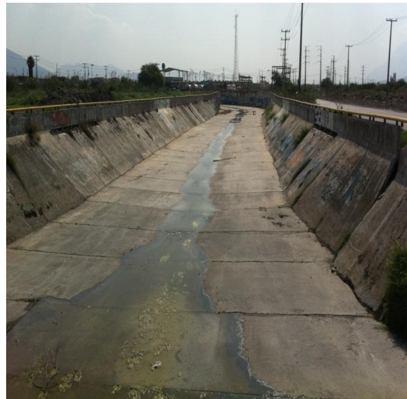
Figura 3.37.- Canalización del arroyo El Águila en el municipio de Monterrey, Nuevo León.
