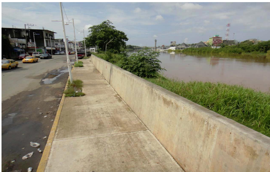
Figura 3.22.- Muro de protección del malecón Leandro Rovirosa Wade en el río Grijalva, Villahermosa, Tabasco.
