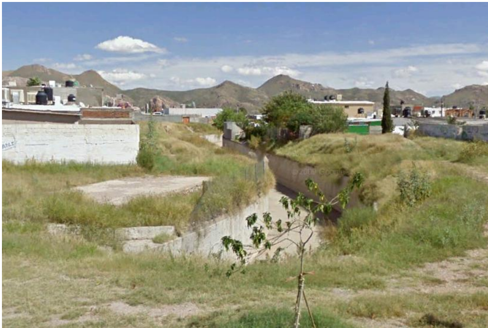
Figura 5.4.- Encauzamiento del arroyo El Mimbres en su primer tramo.
