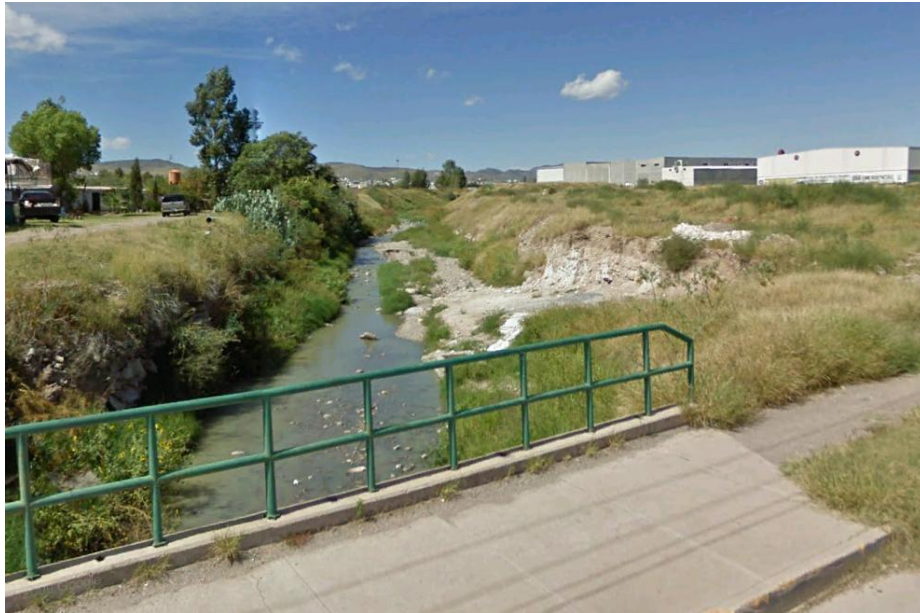
Figura5.8.- Vista del arroyo El Mimbres hacia aguas arriba desde la Av. de las Industrias.
