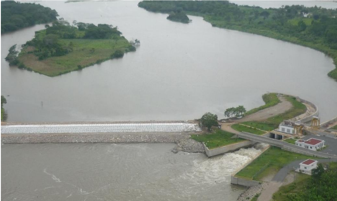
Figura I.1.- Estructura margen izquierda de la obra de control “El Macayo” sobre el río Carrizal, el cual regula el gasto que pasa hacia la Ciudad de Villahermosa, estado de Tabasco.
