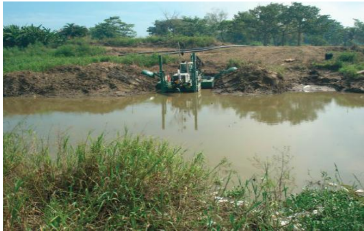
Figura 3.39.- Desazolve del arroyo Zapote II en el municipio de Centro, estado de Tabasco.
