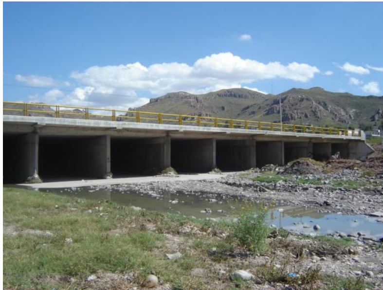
Figura 2.35.- Punto final de la modelación del arroyo El Mimbres, justo antes del puente de la Vialidad Sacramento.
