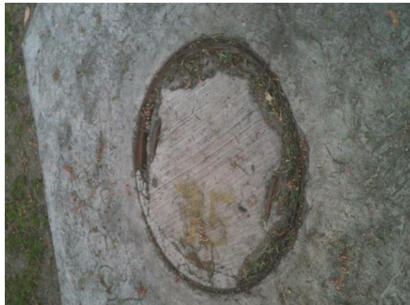
Foto 6.36 Registro del circuito del CUC
