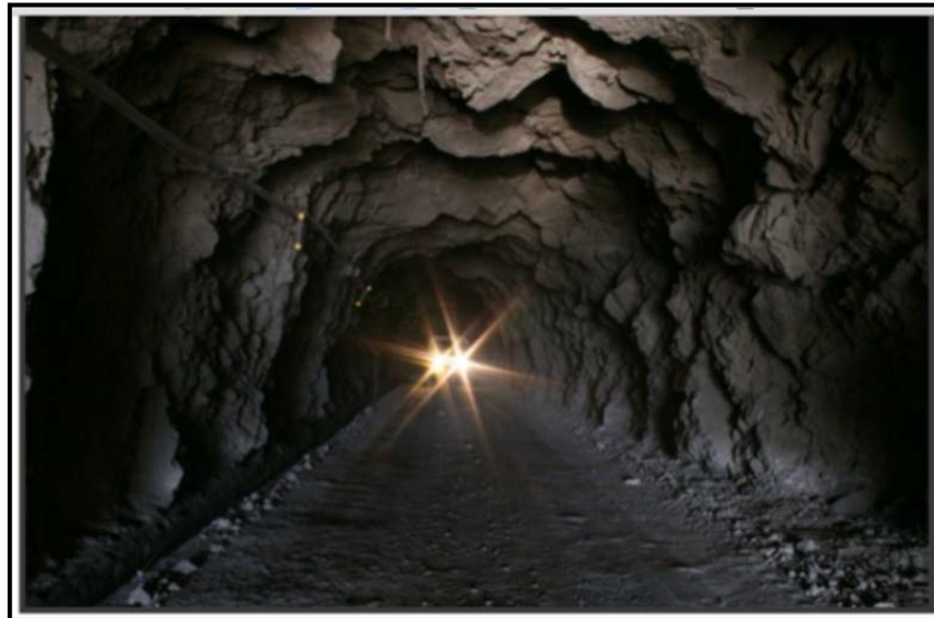
Imagen 4: Túnel de entrada a la mina con una longitud aproximada a los 2 km Fuente:: Proporcionada por la empresa de estudio
