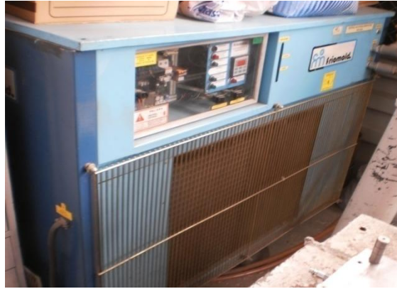
Figura 2.11 Equipo de refrigeración para molde y garganta de alimentación.
