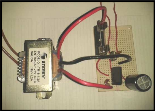
FIGURA 3.2 f: Implementación física del circuito 1 (Fuente de poder)
