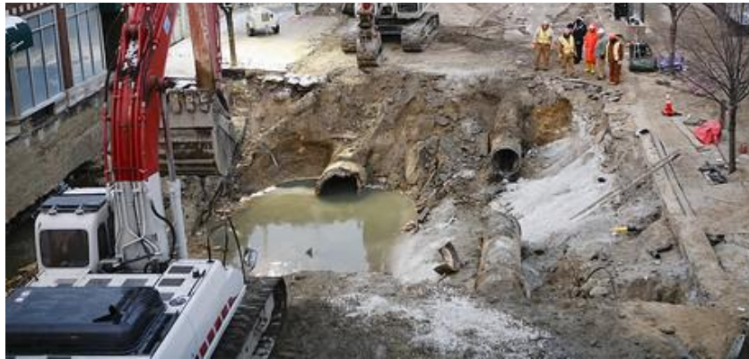
Figura 4.8 Tubos de agua residual (izquierda) y agua potable (derecha)
