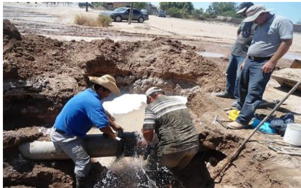
Figura 3.10 Reparación de fugas
