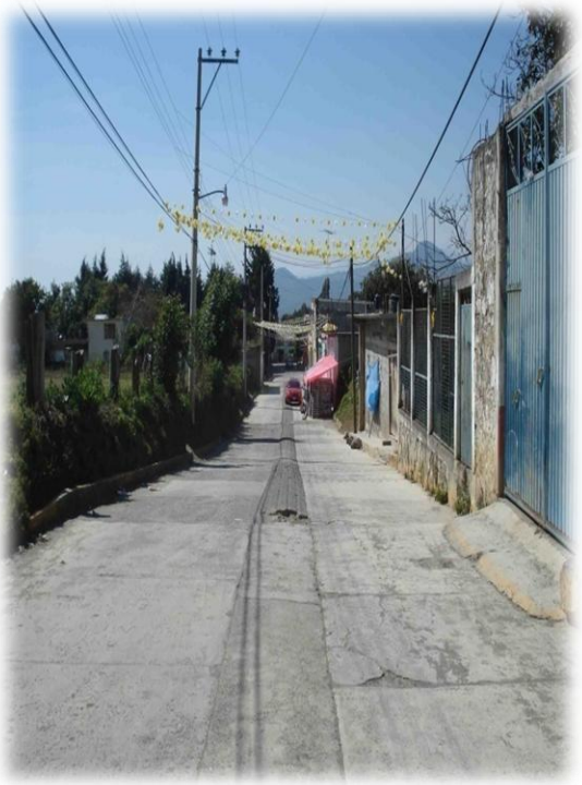
CALLE INDEPENDENCIA (vista del noroeste al noreste)
