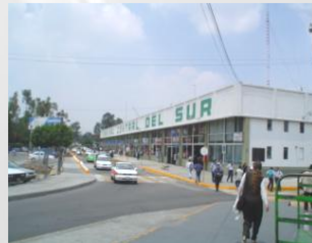
Salida de autos, autobuses y paso peatonal
