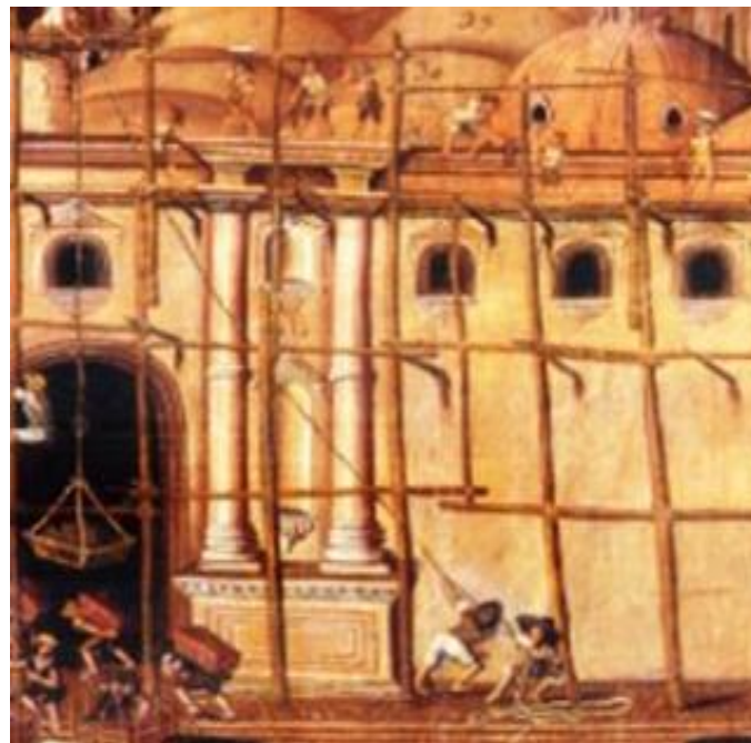
Ilustración 180 Trabajadores elevando una carga por medio de una polea de primer grado en la pintura de Antonio Ramírez de la catedral de Santiago de los Caballeros de Guatemala, 1678
