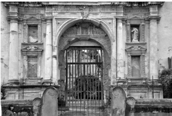
Ilustración 126 Ingreso principal, con los detalles de Joseph de Porres, obsérvese el intercolumnio, igual al de la catedral.
