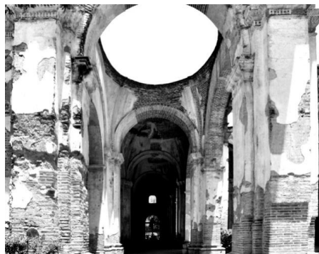
Ilustración 94 Nave lateral, nótese el pronunciado alargamiento de las bóvedas, fotografía del autor, 2010
