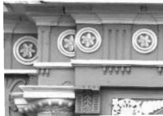
Ilustración 77 Detalle de tetraglifos en el entablamento dórico de la iglesia de San Pedro. Nótese los conflictos de modulación presentes al pasar por tres planos de fachada sucesivos. Fotografía del autor.
