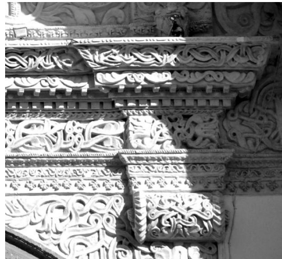
Ilustración 111 Detalle de remate y entablamento sobre ingreso principal, obsérvese el intrincado detalle del ataurique, compárese con ilustración 31. Fotografía del autor, 2012
