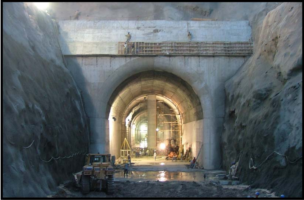
Figura 3.19. Portal de entrada del Túnel No.1, marzo del 2004.
