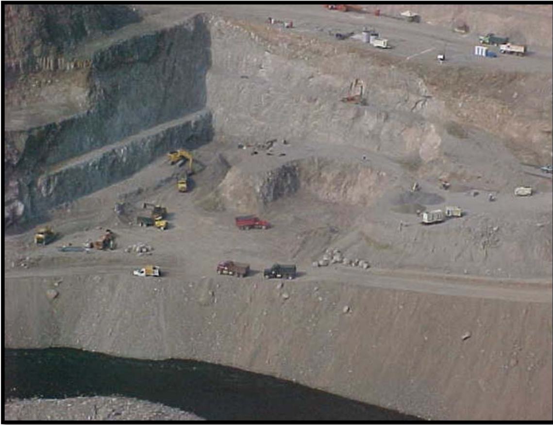
Figura 3.34. P.H. El Cajón – Trabajos de excavación de los portales de entrada de los túneles de desvío, junio del 2003.
