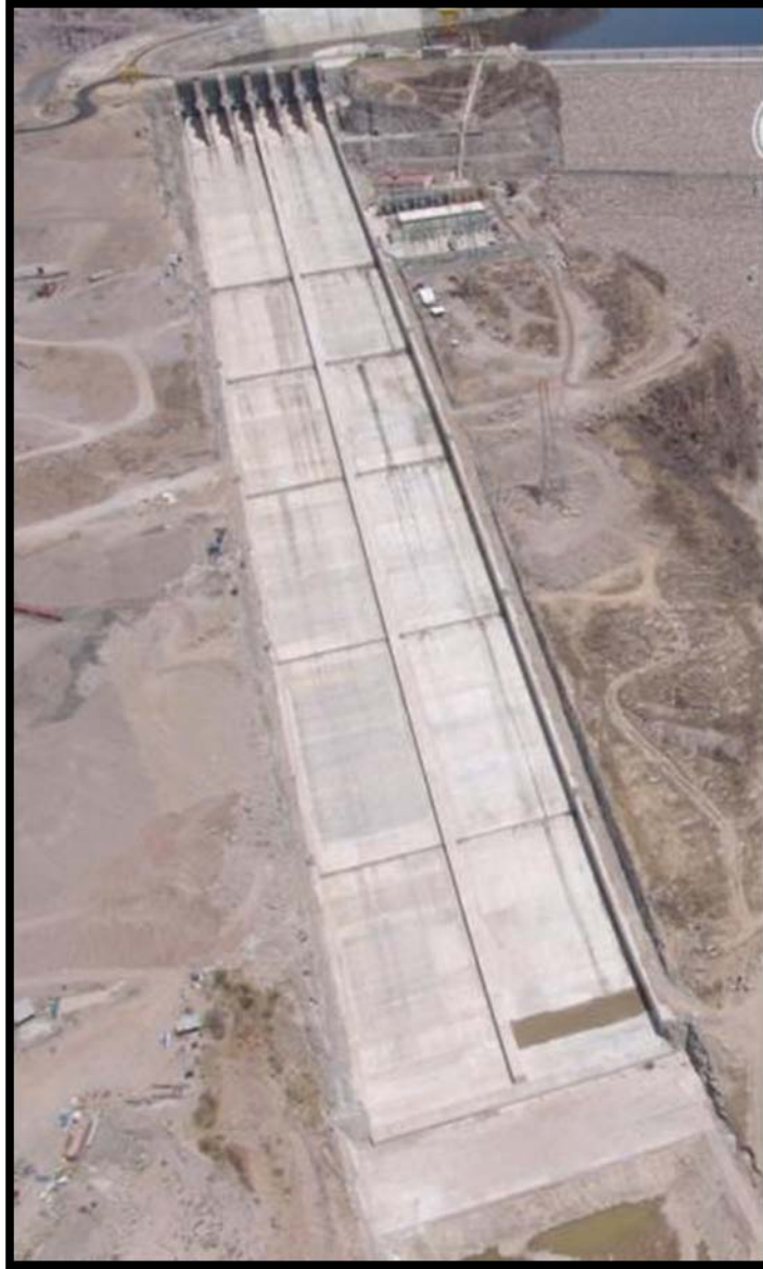
Figura 3.29. Vista del canal de descarga de la obra de excedencias.
