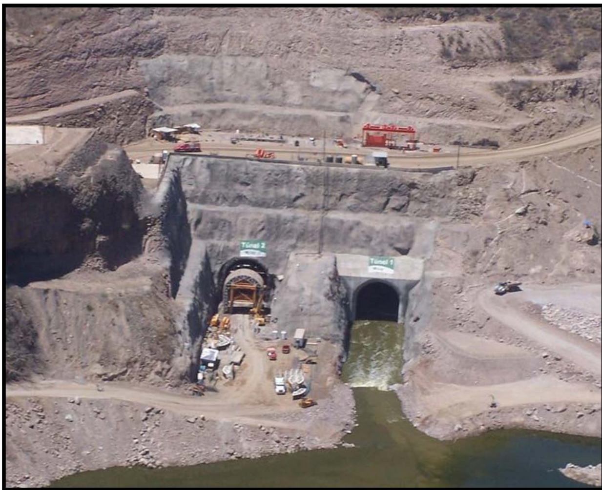
Figura 3.35. P.H. El Cajón – Vista de los Portales de Entrada de los Tuneles de Desvío, abril del 2004.
