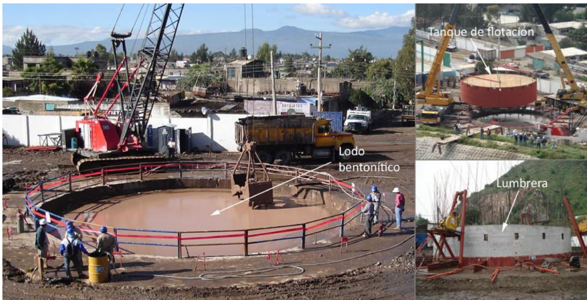
Figura 1. Construcción de lumbrera flotada
