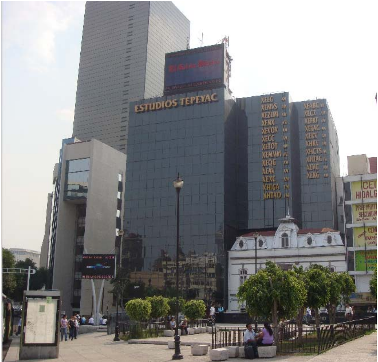
Fachada de Estudios Tepeyac en la Plaza de la Información. Fotografía Leonel Benítez
