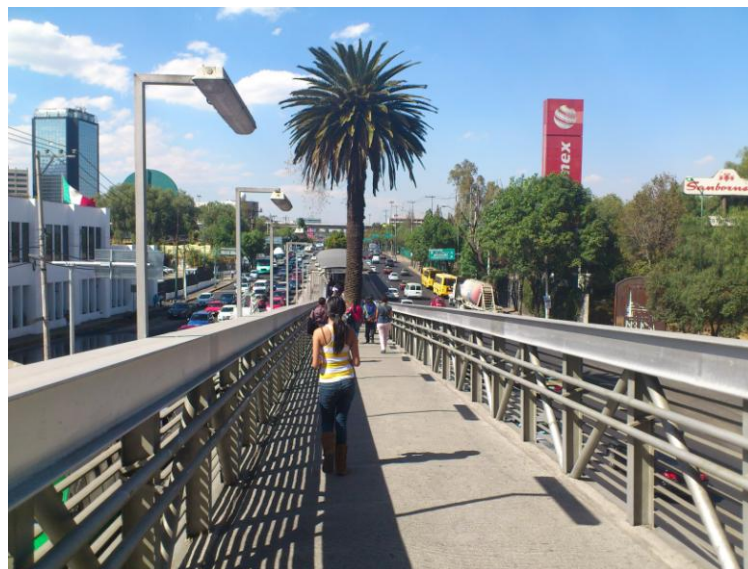
Figura 3-3 Pasillo Villa Olímpica
