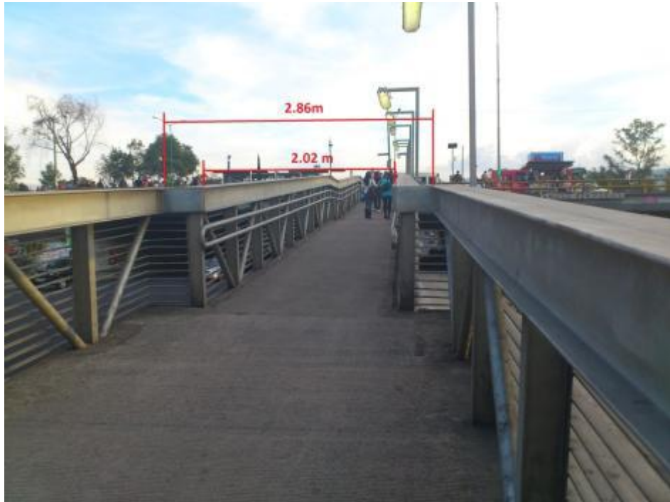
Figura 4-5 Anchos de Pasillo en Perisur
