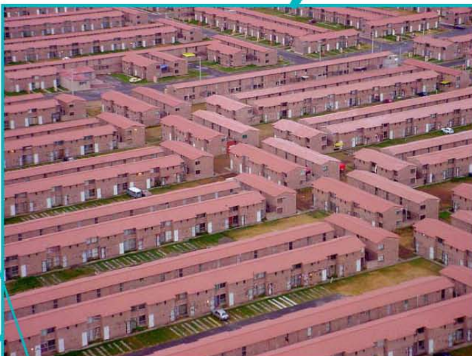
Casas Geo en el pueblo de Tetelpa, en Zacatepec, Morelos.
