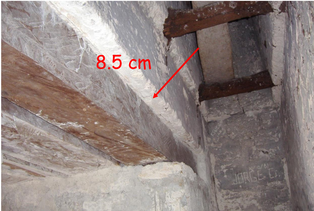
Figura 82. Las vigas de chicozapote puestas por la Universidad de Pennsylvania a principio de 1980. Foto: S. Morselli, 2005.
