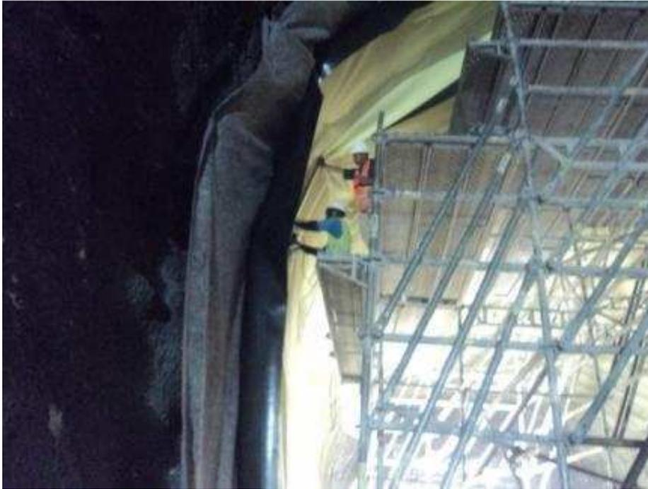
FOTOGRAFÍA IV. 15. Colocación de geotextil y geomembrana (Impermeabilización).
