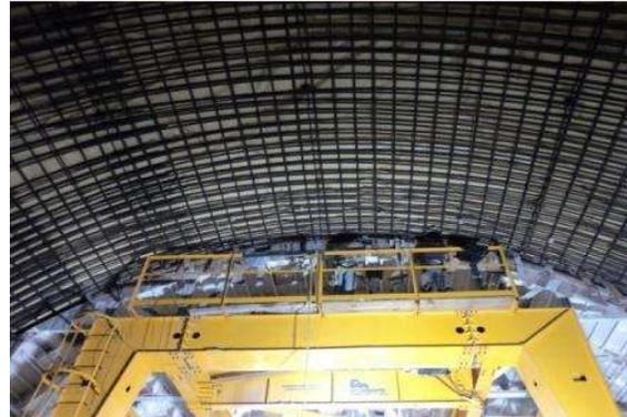
FOTOGRAFIA IV. 17. Construcción de revestimiento definitivo en cuerpo de túnel.
