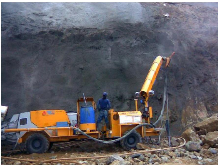
FOTOGRAFÍA IV. 1. Tratamiento en talud, concreto reforzado con malla electrosoldada
