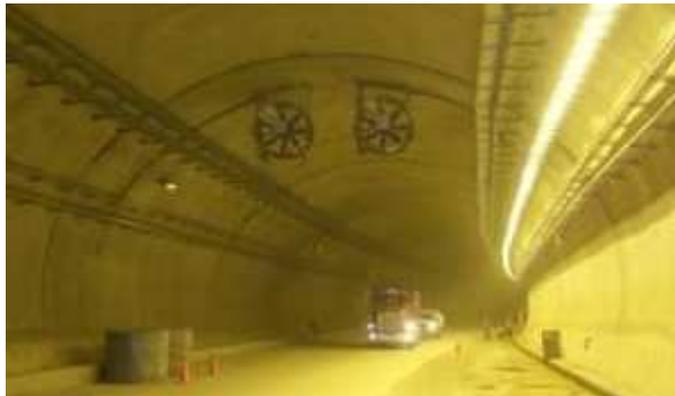
FOTOGRAFÍA IV. 21. Equipos de ventilación.
