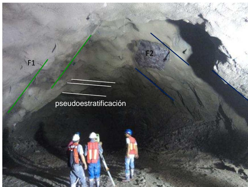
FOTOGRAFIA III. 2. Túnel “El Sinaloense”, caído de origen estructural, causado por pseudoestratificación y diaclasas.
