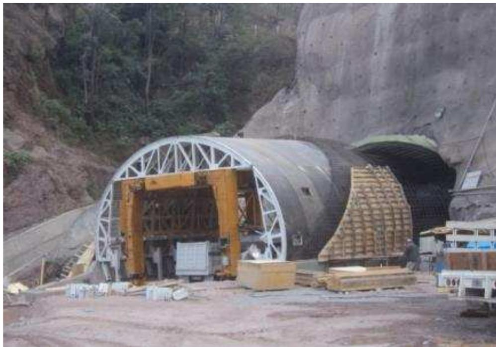
FOTOGRAFÍA IV. 18. Construcción de túnel falso.
