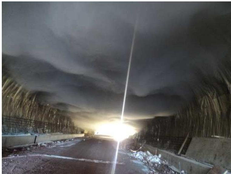
FOTOGRAFÍA IV. 8. Ventilación del túnel, gases tóxicos derivados de voladura y equipos de trabajo.
