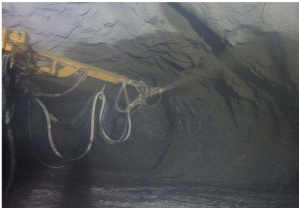
FOTOGRAFIA III. 12. Concreto lanzado en interior de túnel “El Sinaloense” portal Mazatlán.
