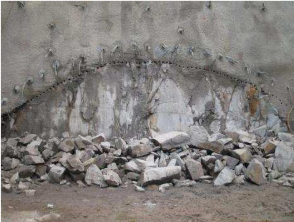
FOTOGRAFÍA IV. 6. Enfilaje (paraguas) en inicio de excavación.
