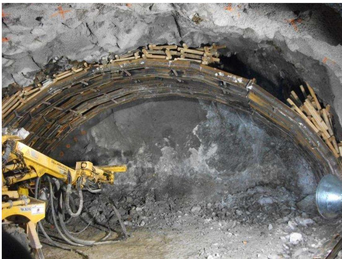
FOTOGRAFIA III. 9. Ejemplo de condición D<sup>(+)</sup>. Túnel “El Sinaloense” portal Mazatlán, roca de calidad mala-regular, clase IV.
