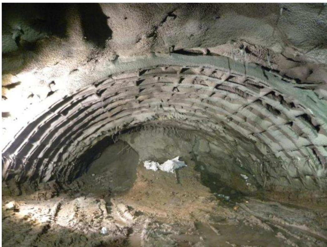
FOTOGRAFIA III. 11. Ejemplo de condición E. Túnel “El Sinaloense” portal Durango. Avance en dos fases hastiales y piloto central.
