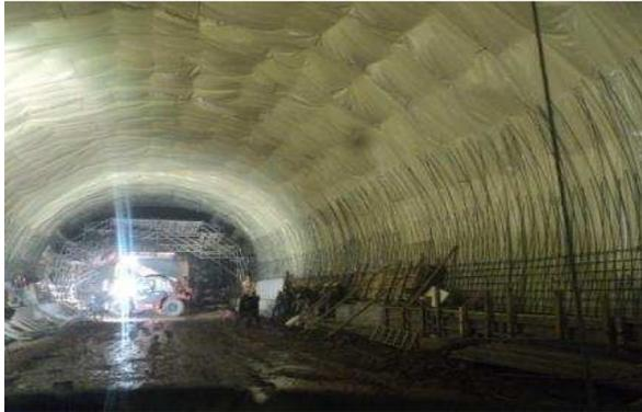
FOTOGRAFIA IV. 16. Revestimiento definitivo, construcción de zapata y guarnición.
