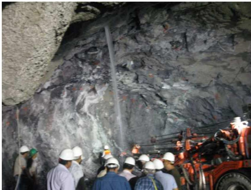
FOTOGRAFIA III. 4. Salida puntual de agua en clave.
