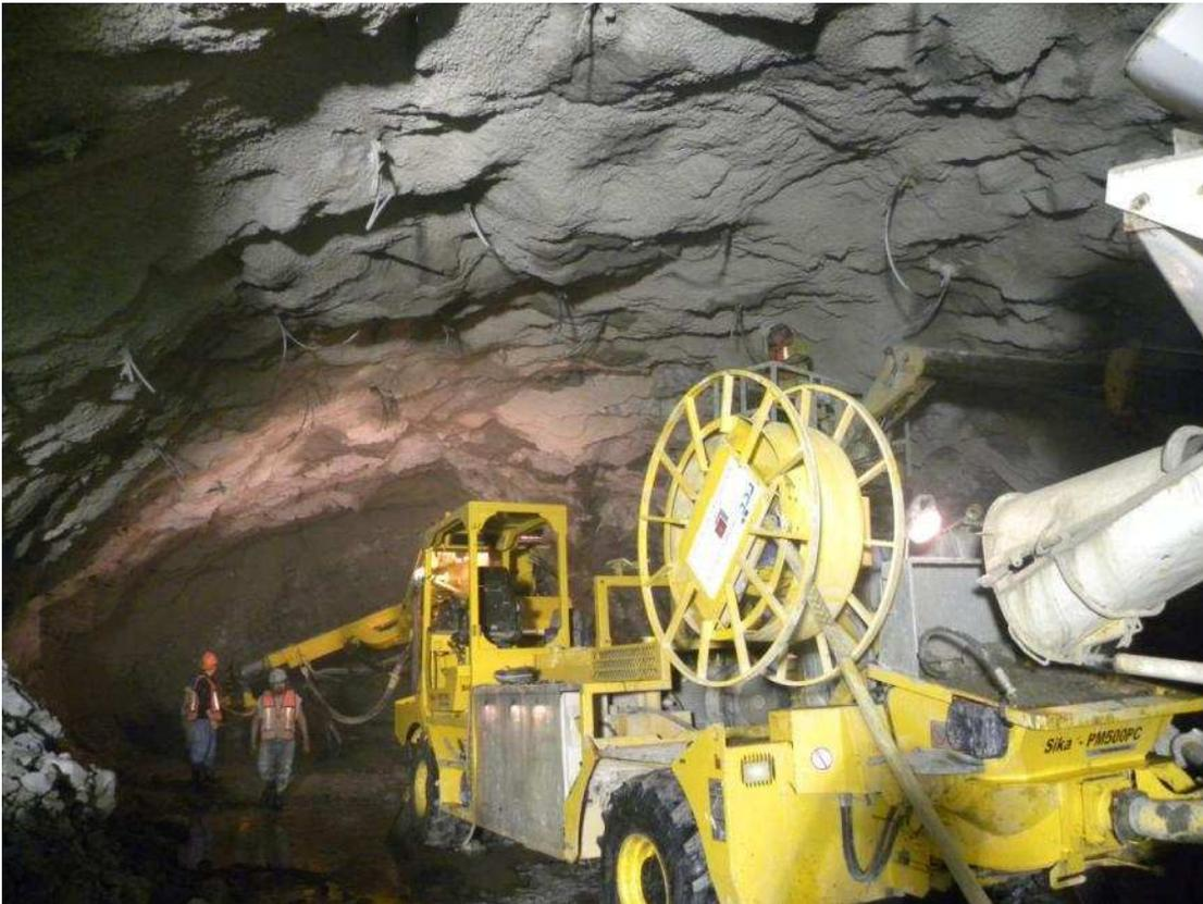
FOTOGRAFÍA IV. 9. Equipo que se utiliza para lanzar concreto.
