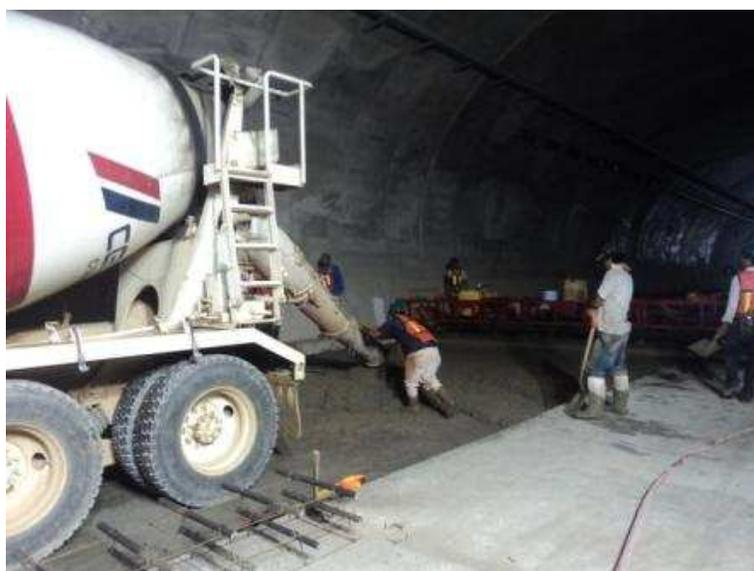
FOTOGRAFÍA IV. 19. Colocación de concreto hidráulico en pavimentación.
