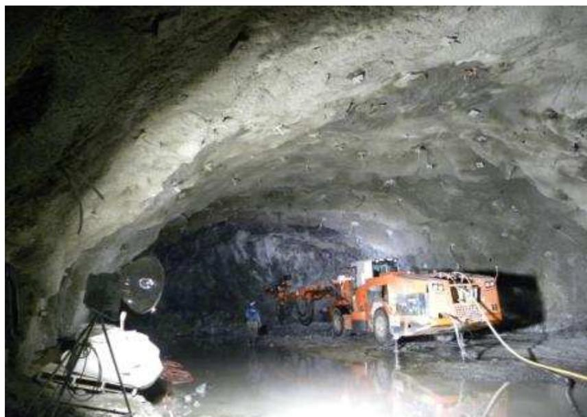
FOTOGRAFIA III. 7. Ejemplo de tratamiento en condición C<sup>(+)</sup>. Anclas radiales colocadas en patrón 2.0x2.0.
