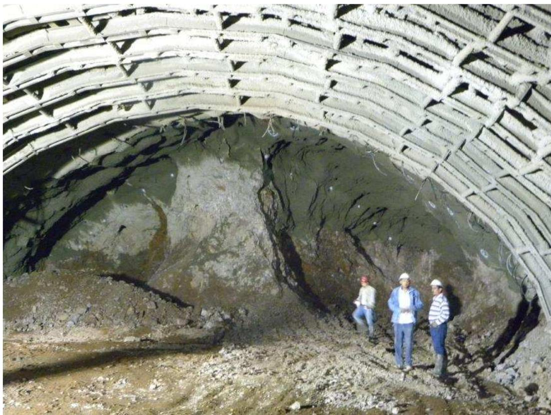
FOTOGRAFIA III. 8. Ejemplo condición C<sup>(-)</sup>. Túnel “El Sinaloense”, excavación de media sección en 2 etapas, se observa el avance en hastiales y el piloto central.
