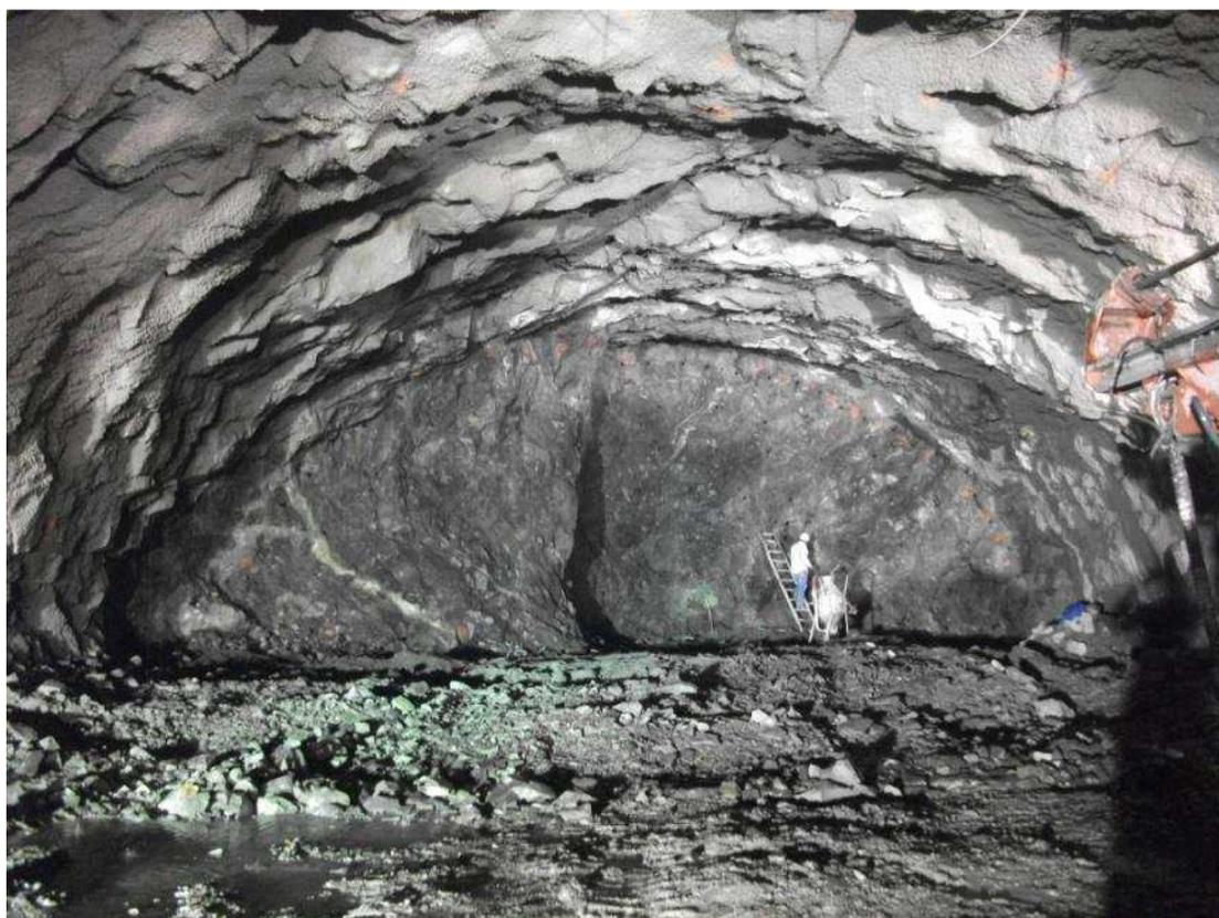
FOTOGRAFIA III. 6. Ejemplo de condición B. Túnel "El Sinaloense" portal Mazatlán, roca de calidad buena, clase II.
