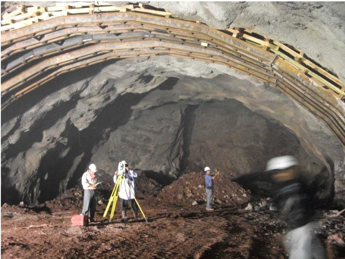
FOTOGRAFIA V. 3. Se observa sobreexcavación derivados de pequeñas cuñas en la clave.
