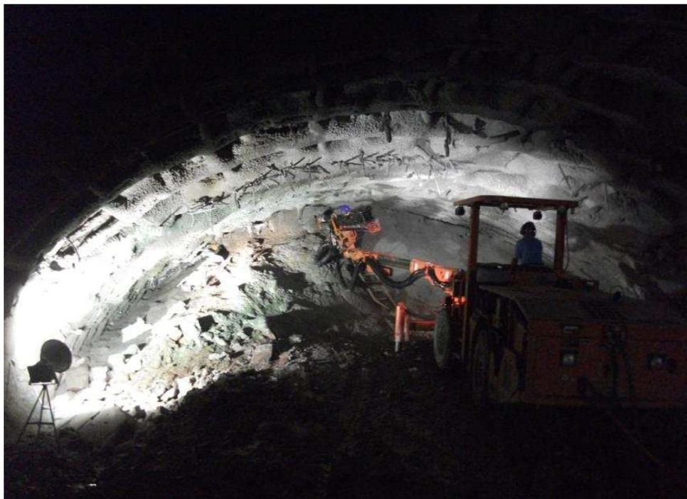
FOTOGRAFÍA IV. 12. Barrenación para enfilaje en túnel "El Sinaloense" portal Durango.
