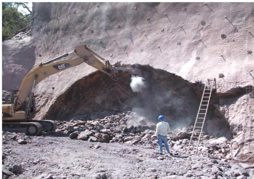
FOTOGRAFÍA IV. 7. Inicio de excavación con medios mecánicos, en portal Durango del túnel "El Sinaloense".
