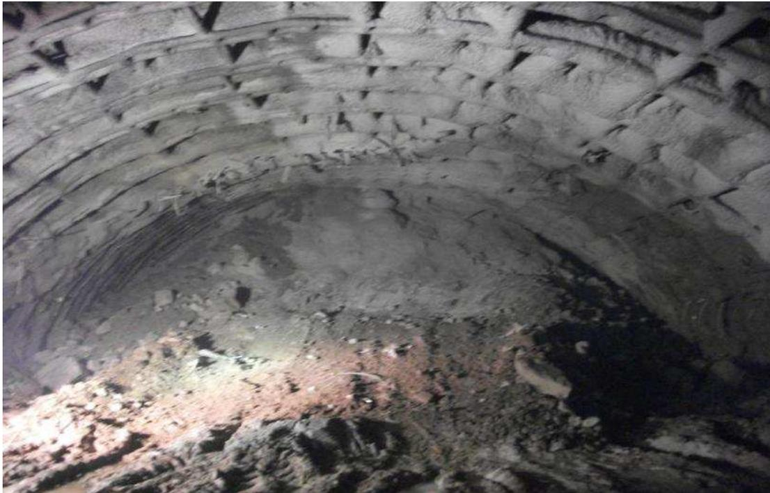
FOTOGRAFIA V. 2. Trabajos realizados para estabilizar la zona de caído.
