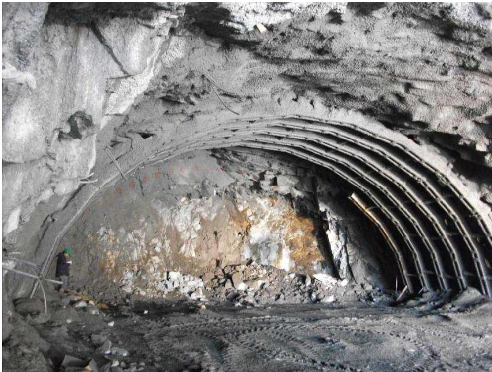
FOTOGRAFIA III. 14. Colocación de marcos metálicos, se observa la colocación en secciones.
