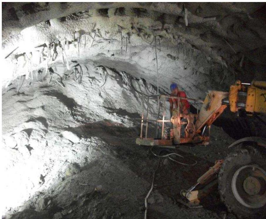
FOTOGRAFIA III. 15. Enfilaje colocados en el Túnel "El Sinaloense" portal Durango.
