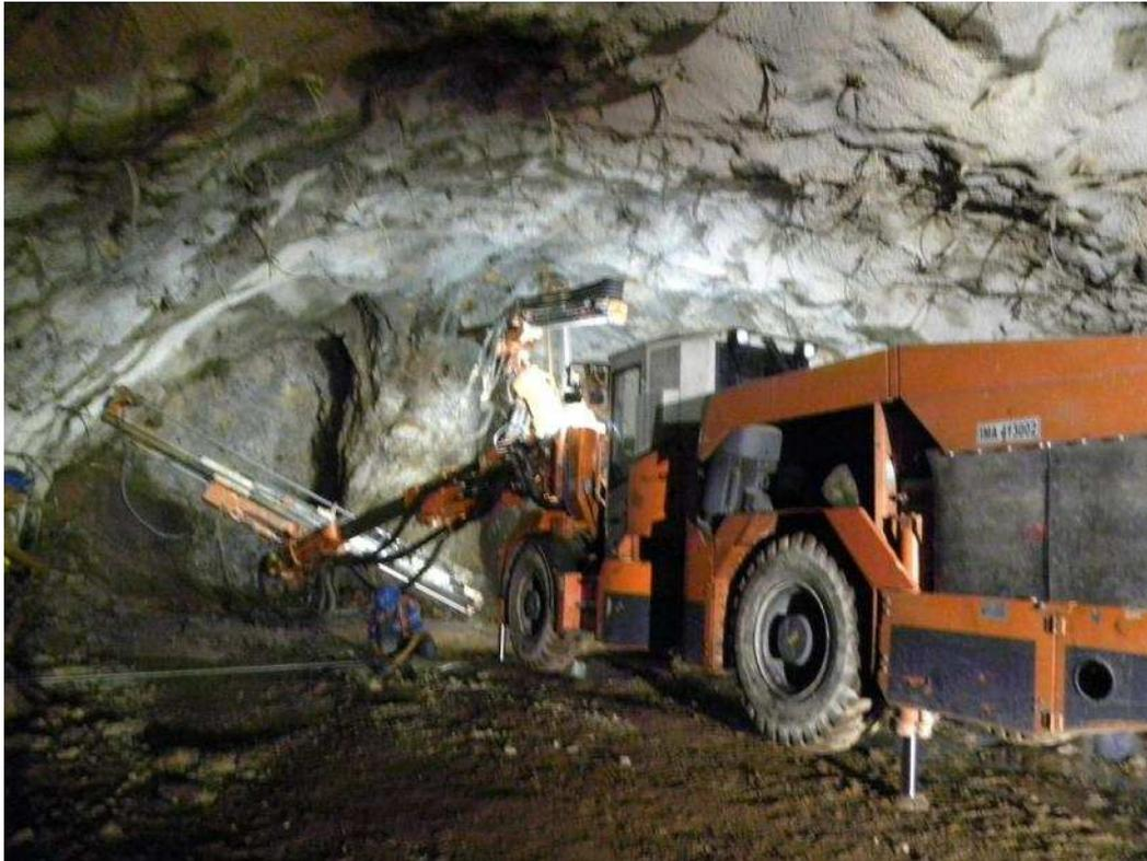
FOTOGRAFIA III. 13. Barrenación de anclaje para sostenimiento C.
