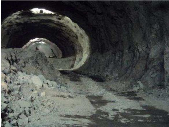
FOTOGRAFÍA IV. 13. Banqueo al fondo se observa un track drill, con éste equipo se realiza la barrenación.
