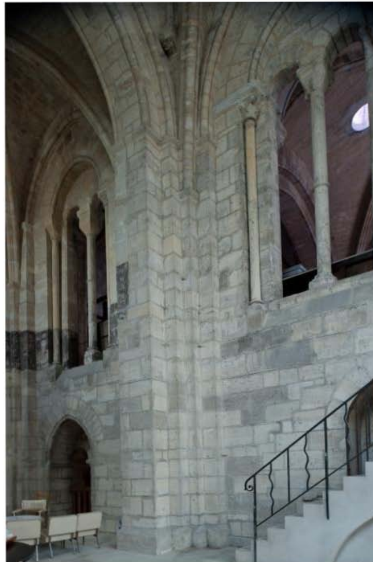
9. Interior, torre norte vista hacia el sureste.
