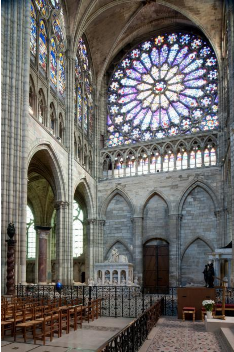
20. Interior, cruce con vista al noroeste hacia el transepto norte.
