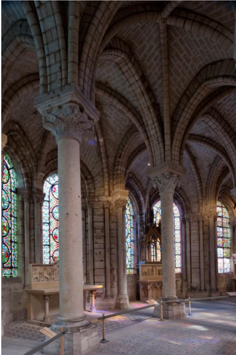
15. Interior, cabecera, deambulatorio norte con vista hacia el sureste.
