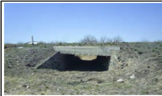
FIG. 7 LOSA DE CONCRETO SIMPLE DE 3.5 M DE LUZ POR 1.5M DE ALTURA, CON ALEROS DE MAMPOSTERÍA. (PARRAL, CHIHUAHUA).
