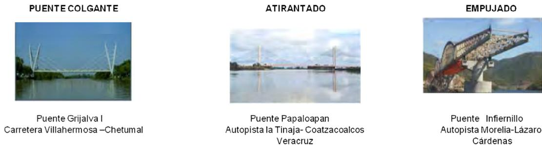
FIG. 12.- REPRESENTACIÓN DE LOS PUENTES COLGANTE, ATIRANTADO Y EMPUJADO RESPECTIVAMENTE
