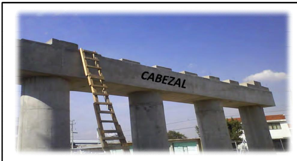
FIG. 25 MUESTRA DE CABEZAL, EN LA PARTE SUPERIOR SE OBSERVAN LOS BANCOS DONDE DESCANSARAN LAS TRABES Y EN LA PARTE INFERIOR EL SISTEMA DE PILA QUE JUNTO CON EL CABEZAL FORMAN UN MARCO CON TRES CRUJÍAS.
