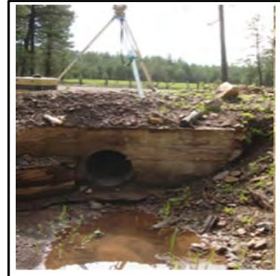
FIG. 6 TUBO DE LÁMINA DE 0.90M.  $\Phi$
