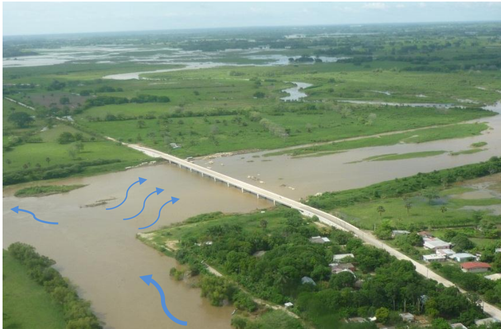
Figura 22. Cauce de alivio el Censo, en la cual se aprecia el azolve tanto a lo largo como a lo ancho. Fuente CONAGUA.
