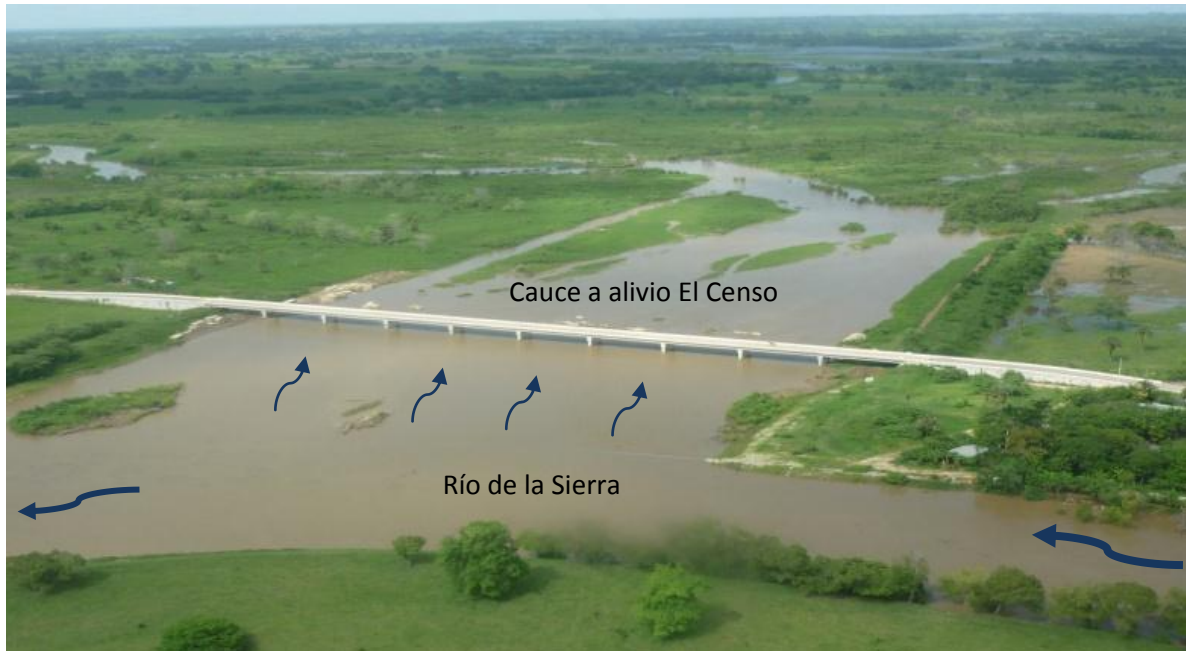
Figura 6. Cauce de alivio el Censo sobre la margen derecha del río de la Sierra. Fuente CONAGUA
