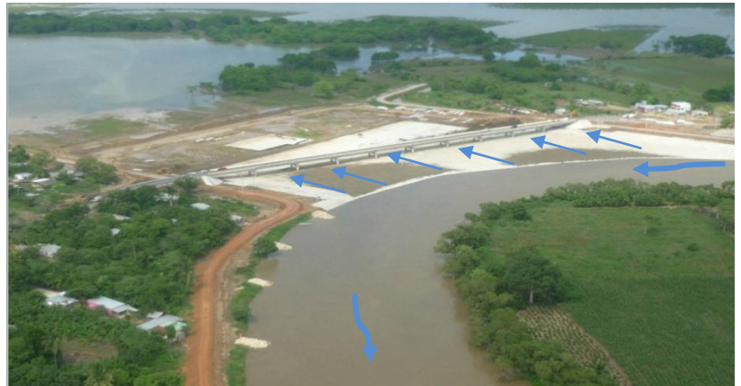
Figura 28. Cauce de alivio Sabanilla. Fuente CONAGUA.
