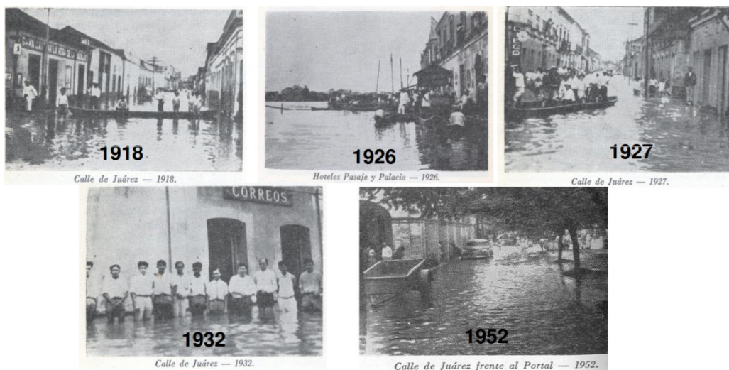
Figura 2. Diversas inundaciones en el estado de Tabasco. Fuente II UNAM
