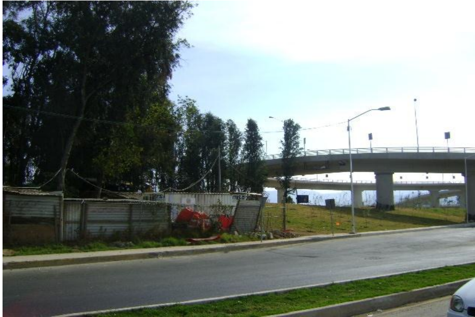
FOTO-1 VISTA FRONTAL NORPONIENTE, TOMADA DESDE EL PERIFERICO
