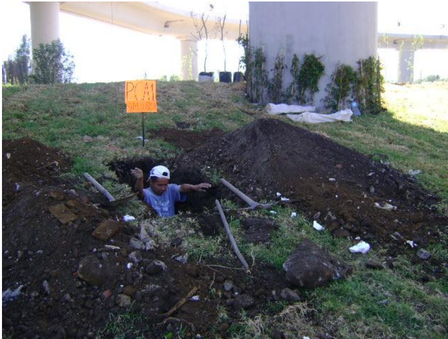
FOTO-5 BORDO DEL CANAL EXISTENTE EN LA COLINDANCIA SUR DEL TERRENO
