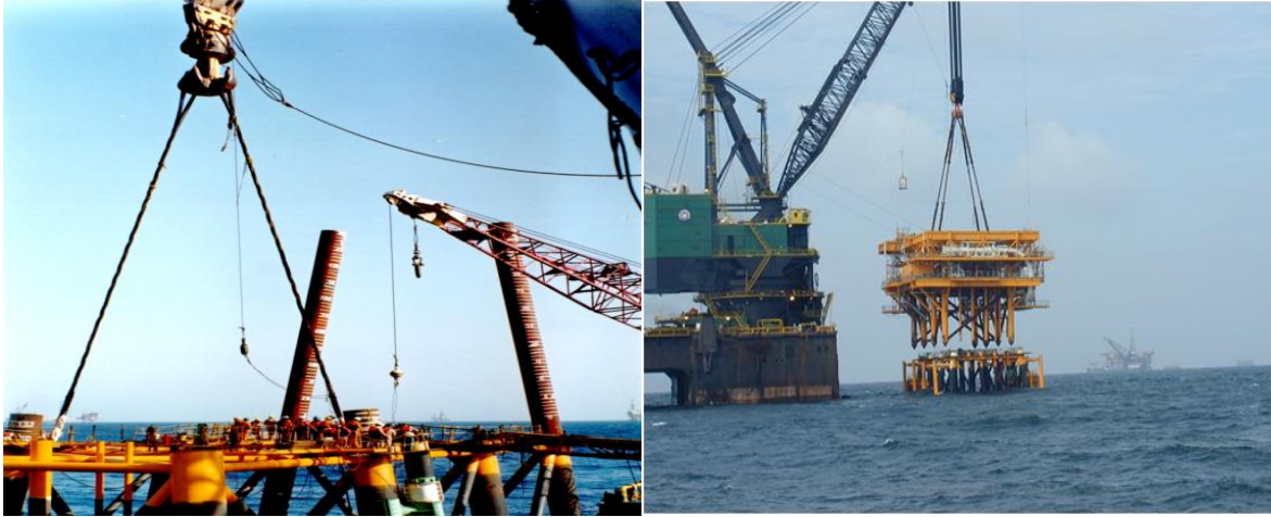
Figura 13. Instalación de plataformas marinas
