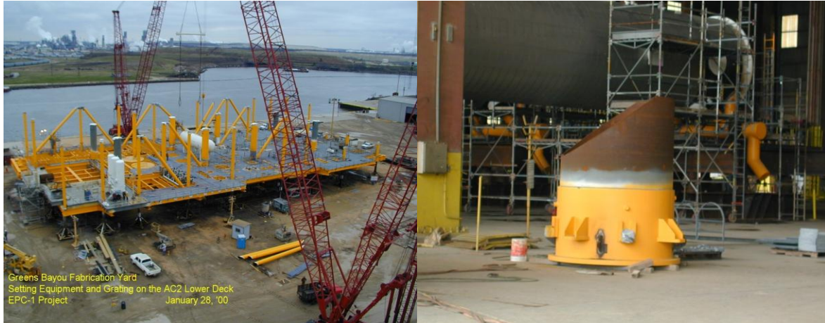
Figura.10. Fabricación de plataformas marinas
