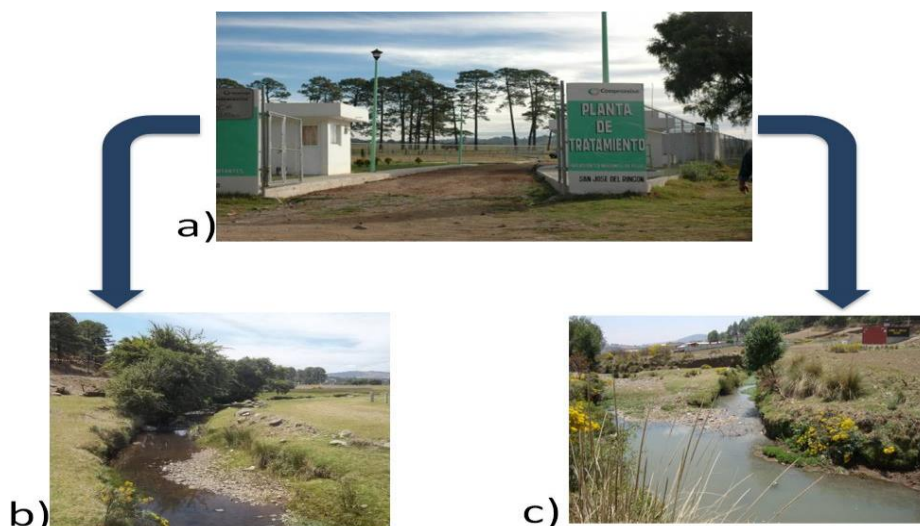
Figura 3. a) Vista de la planta de tratamiento (PT) de San José del Rincón, Estado de México, b) sitio 1 ubicado en el río San José del Rincón 100 m antes de la entrada a la PT, c) sitio 2 localizado en el cauce del río, 100 m después de la PT.
