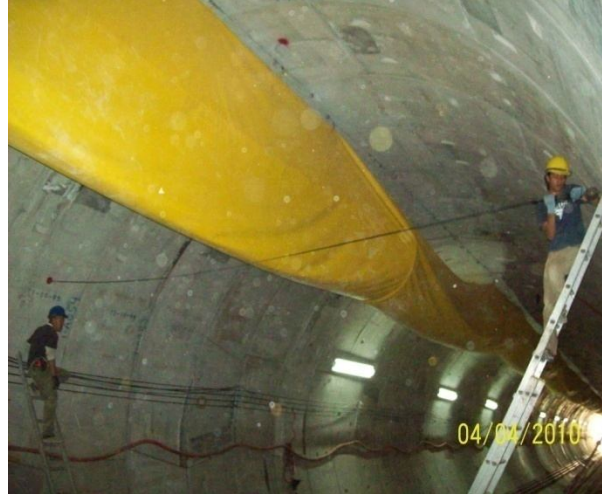
Foto 1a. Lectura de convergencia en túnel.
