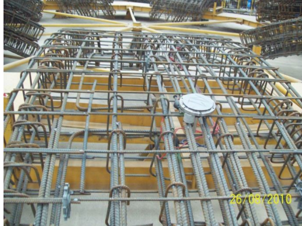
Foto 10a. Colocación de celda de presión en dovela de revestimiento primario en TEO.
