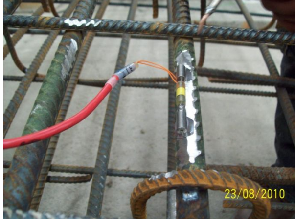
Foto 9a. Colocación de deformímetro para monitoreo del acero en dovela de revestimiento primario en TEO.
