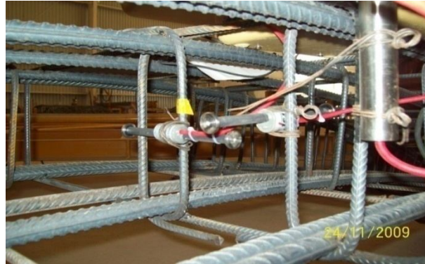
Foto 8a. Colocación de deformímetros para monitoreo del concreto en dovela de revestimiento primario en TEO.
