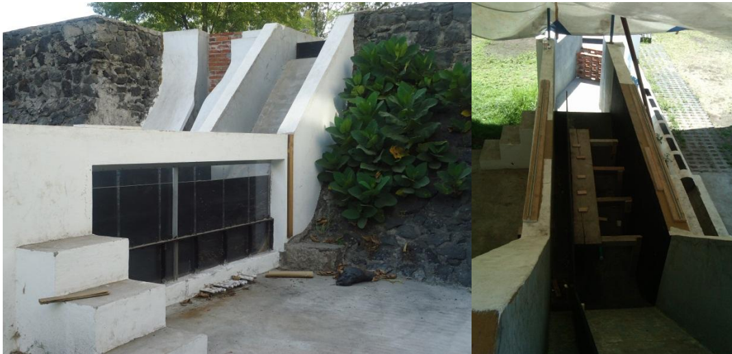
Figura 3.7 Tanque amortiguador modificado
