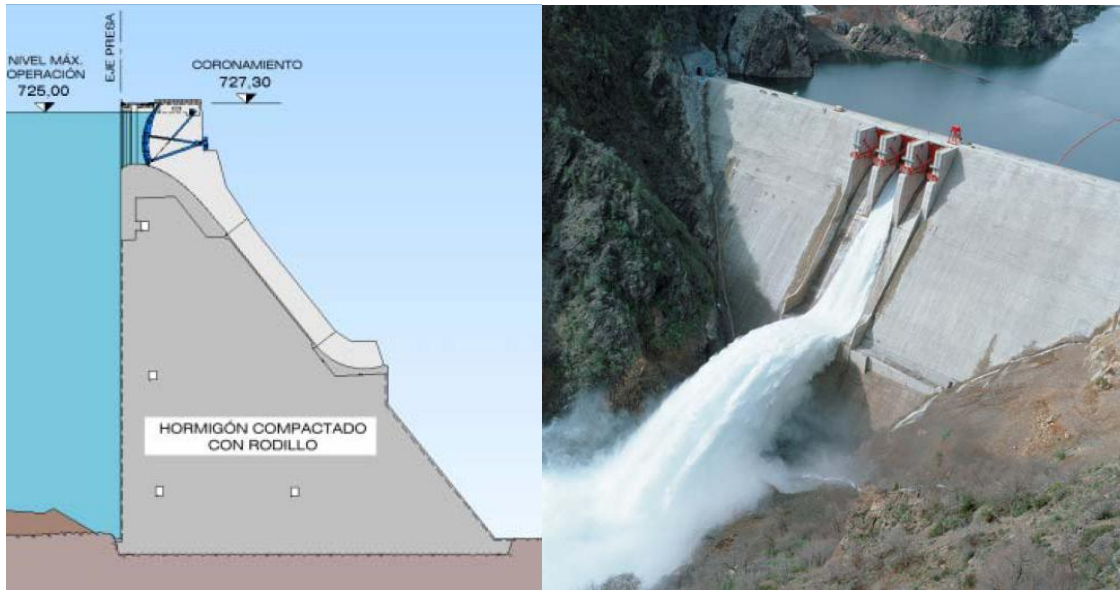
Figura 2.11 Ejemplo de la operación de la obra de excedencias, Presa Ralco, Argentina
