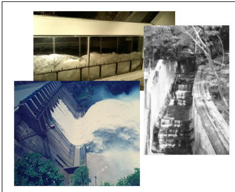
Figura 2.3 Ejemplos de disipadores de energía.
