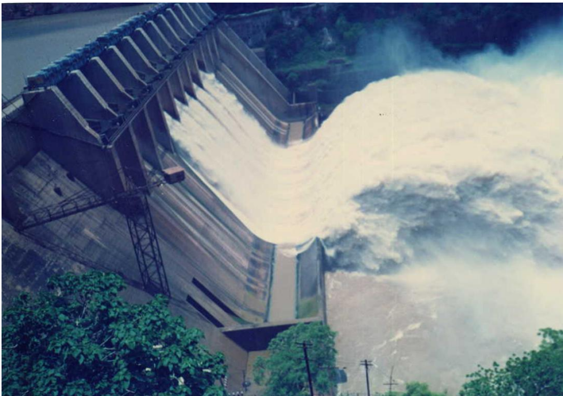
Figura 2.6 Operación la cubeta de lanzamiento o salto de esquí.
