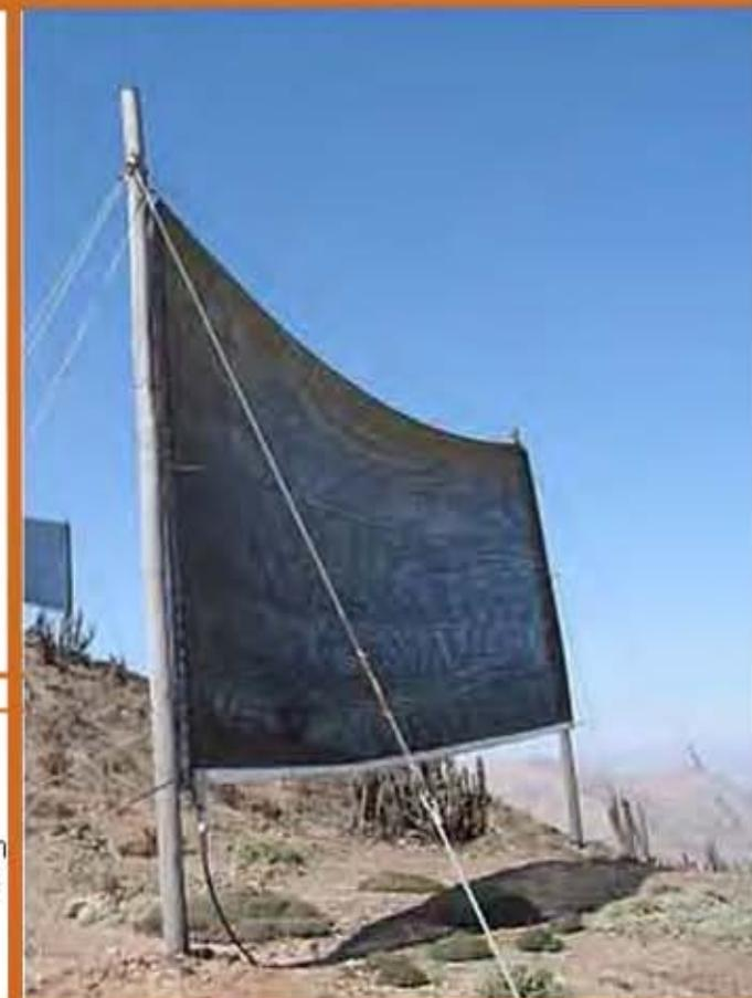
Al amanecer, cuando la niebla se retira, reaparece la silueta de los atrapanieblas, pero con una novedad: las gotas de esta "agua nueva" han sido capturadas por las mallas y son conducidas a través de una canaleta hasta una cañería, para ser destinadas a riego o a consumo de los pobladores, según sea el caso.
