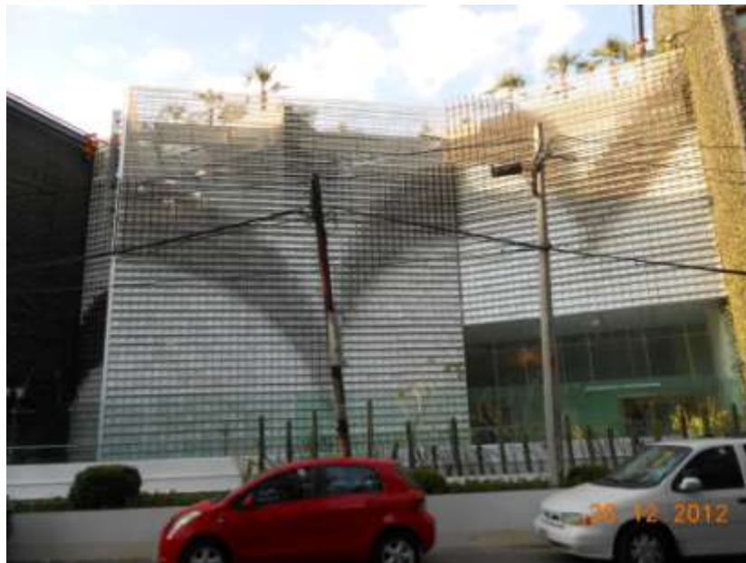
Figura I.3. Vista Fachada Principal
