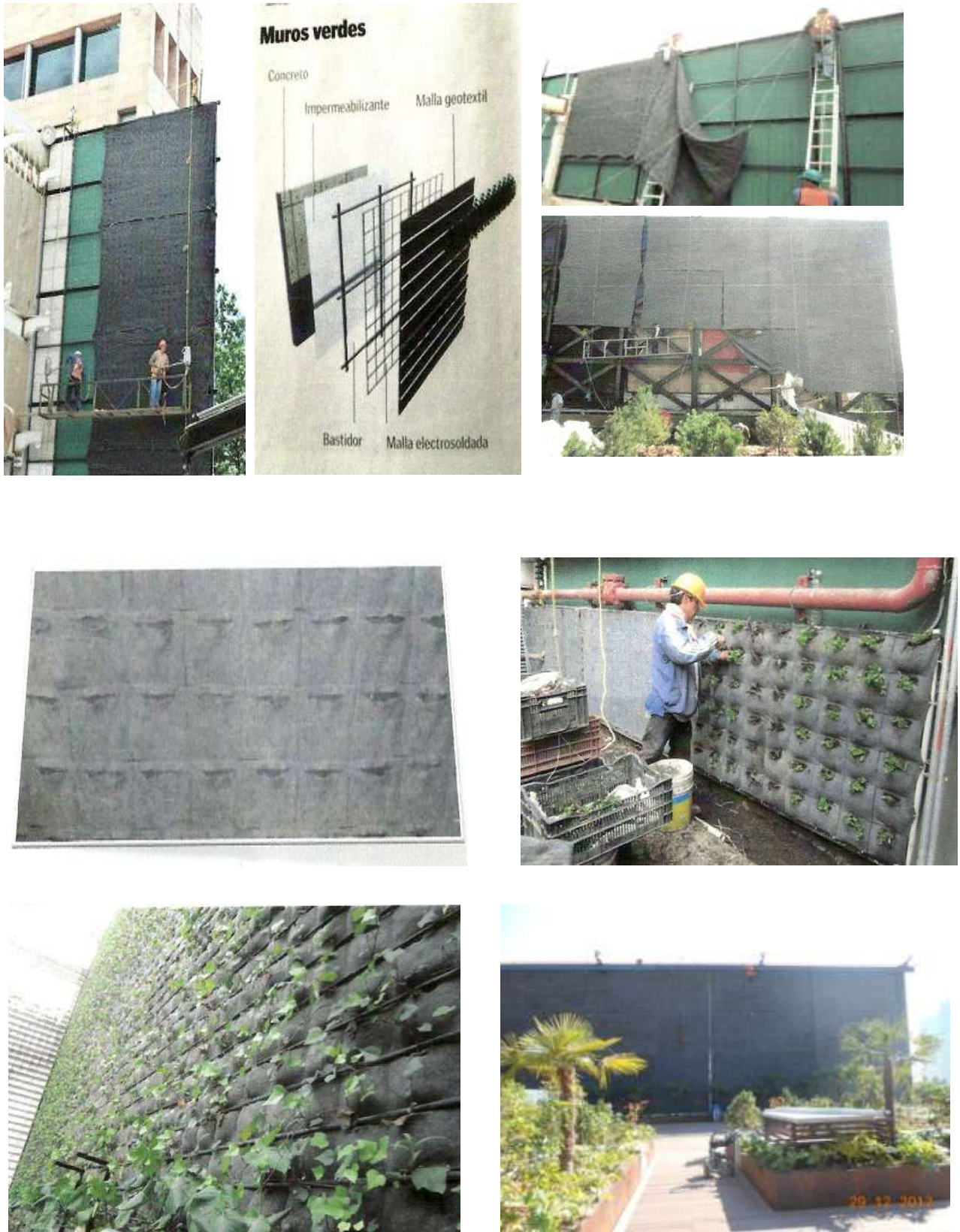
Figura II.18 Procedimiento constructivo en Muros Verdes
