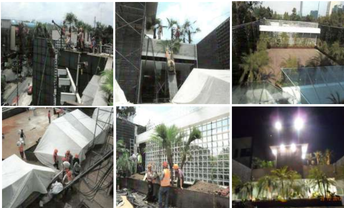
Figura II.16 Procedimiento constructivo en Jardineras Horizontales en Tercer Nivel
