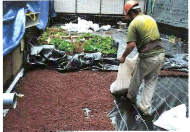
Figura II.14 Preparación del terreno con Filtro de Gravas
