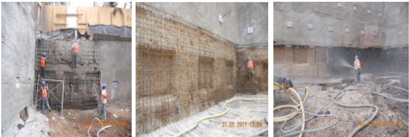
Figura IV.2 Colocación del Armado en muro de contención y colocación de Concreto lanzado
