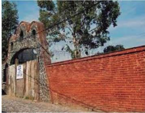
1. Vista lateral de una de las callejuelas del Pueblo
