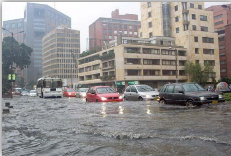
Figura 20.- Inundaciones causadas por un mal diseño hidráulico
