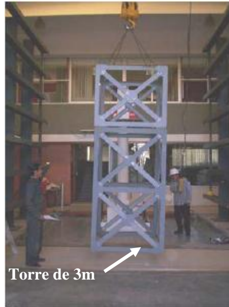
Figura 3.22. Transporte de torre metálica
