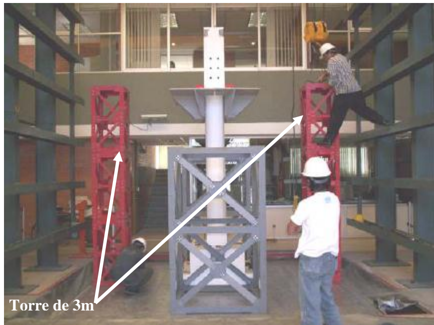
Figura 3.23. Transporte de piezas sobre la mesa vibradora
