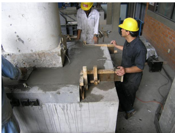
Figura 3.17. Acabado de la conexión postensada cimentación-columna
