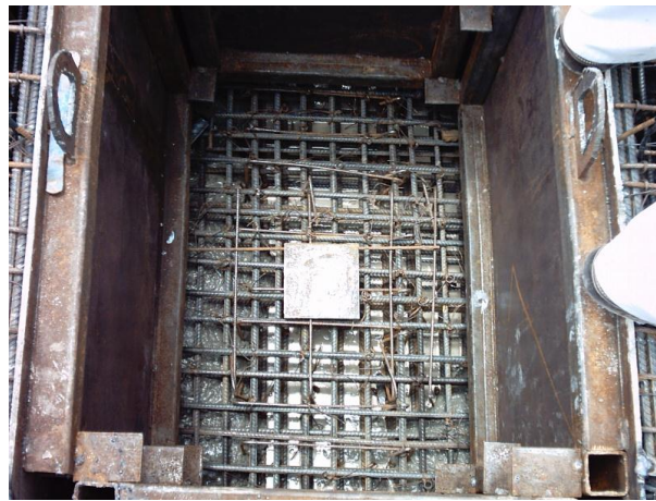
Figura 3.8 Varillas de refuerzo y cimbra metálica de zapata 1-A
