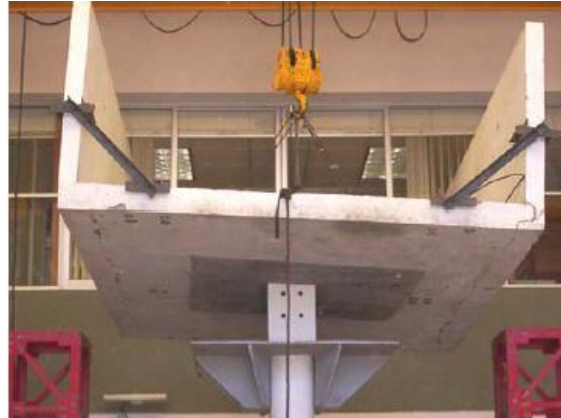
(b) Ensamble de caja de concreto
