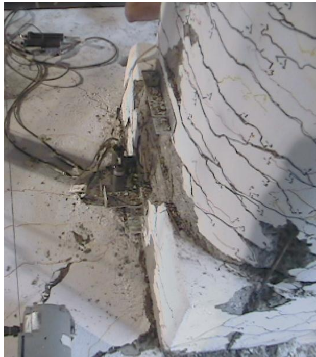
Figura 4. 25 Daño en espécimen 2-A bajo control por desplazamientos, ductilidad 6, ciclo 1
