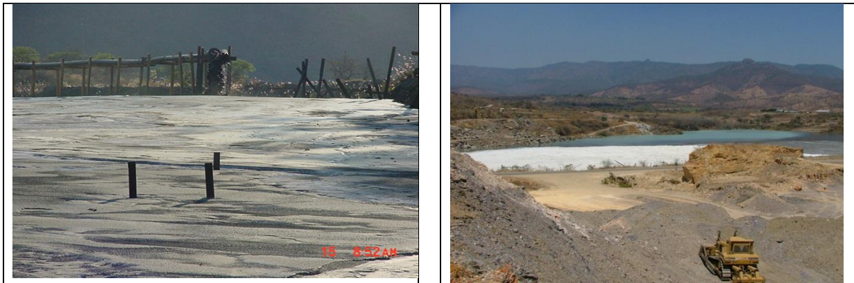
Fig. 1.4. Dos vistas de una presa de jales donde se recolecta el agua por decantación (Pacheco-Gutiérrez, 2006)
