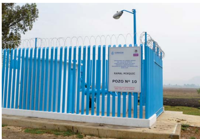
Figura 5.7 Batería de pozos Mixquic-Sta.Catarina (THU, 2012)
