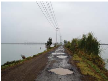
Figura 6.23 Batería de pozos Mixquic- Santa Catarina (THU, 2012)
