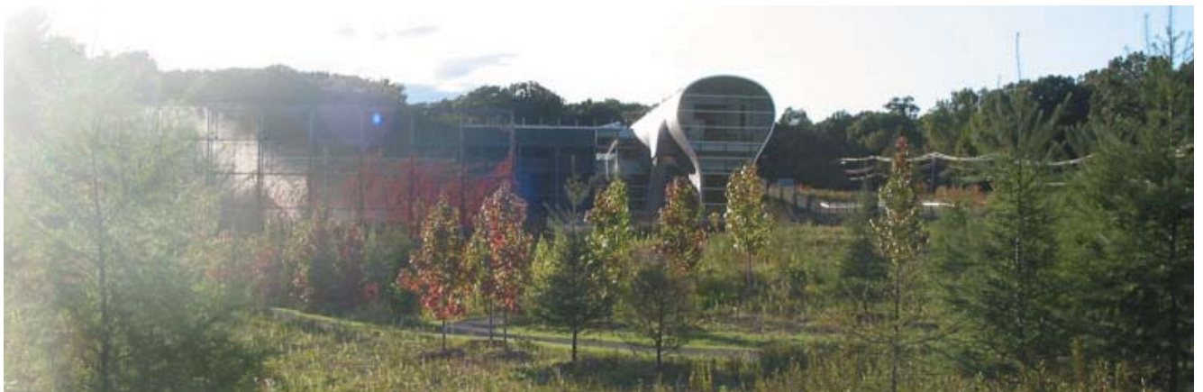
Análogo de la Planta Potabilizadora de Agua Whitney en New Heaven Connecticut
