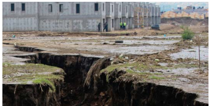
Figura 3.3 Grietas del suelo, Municipio de Chalco, Estado de México (Huerta, 2012)
