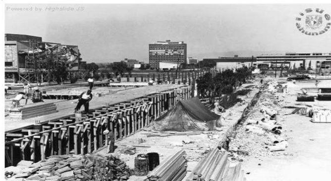
Fig. 1.1 Vista general de Ciudad Universitaria durante su construcción, 25 de septiembre de 1953 IISUE/AHUNAM/Colección Universidad, doc. 3305.
