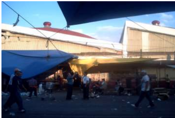
Mercado de zona 14 en total deterioro, basura en las calles, lonas y catres encadenados a las paredes del mercado. Tepito 2010. Foto Angélica Hernández Iruiz.
