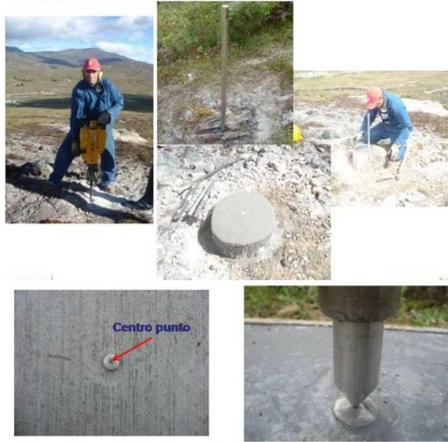
Figura 4.3: Monumentación tipo incrustación. Superior :Proceso de instalación. Inferior : Vista en planta del punto central (hueco). Tomada de Campañas de campo con propósitos geodinámicos , página web del proyecto GEORED http://geored.ingegominas.gov.co/index.php/es/memorias-iii-taller-de-aplicaciones-cientificas-gnss-en-colombia .
