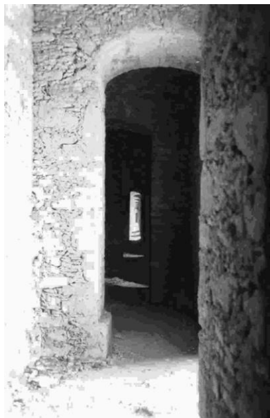
Fotografía 3.3 Horno de fundición de la Negociación Minera y Beneficiadora de Pozos, S.A. (2003)
