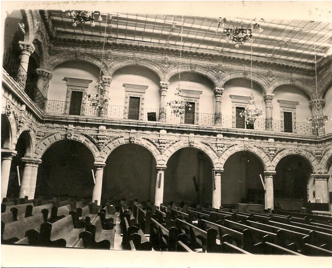
Vista interior del Patio de los Portales
