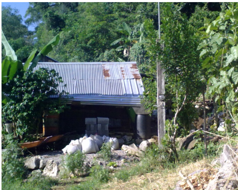
Fig. 4 Viviendas de Peña Blanca. Fuente: Fotografía directa, 2011.
